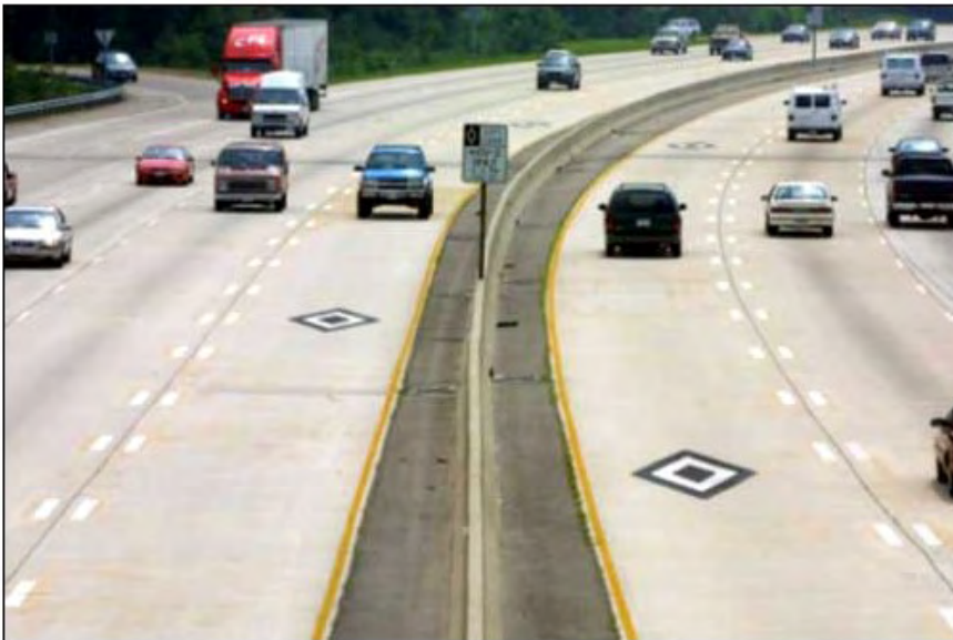
Σχήμα 3.26: Μη διαχωρισμένες λωρίδες για οχήματα υψηλής πλήρωσης. (Πηγή: FHWA, 2003)
