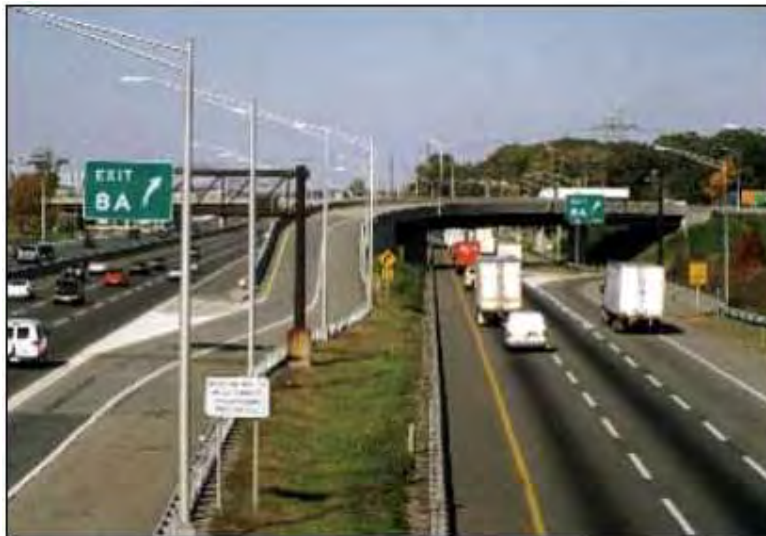
Σχήμα 3.18: Χωριστή λωρίδα για βαρέα οχήματα (Πηγή: FHWA, 2003)
