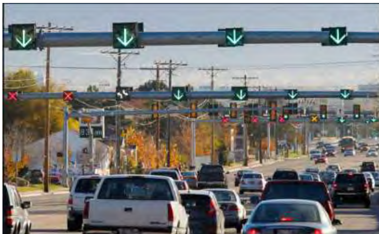
Σχήμα 3.19: Φωτεινές πινακίδες χρήσης/αποκλεισμού λωρίδων (Πηγή: archive.sltrib.com)
