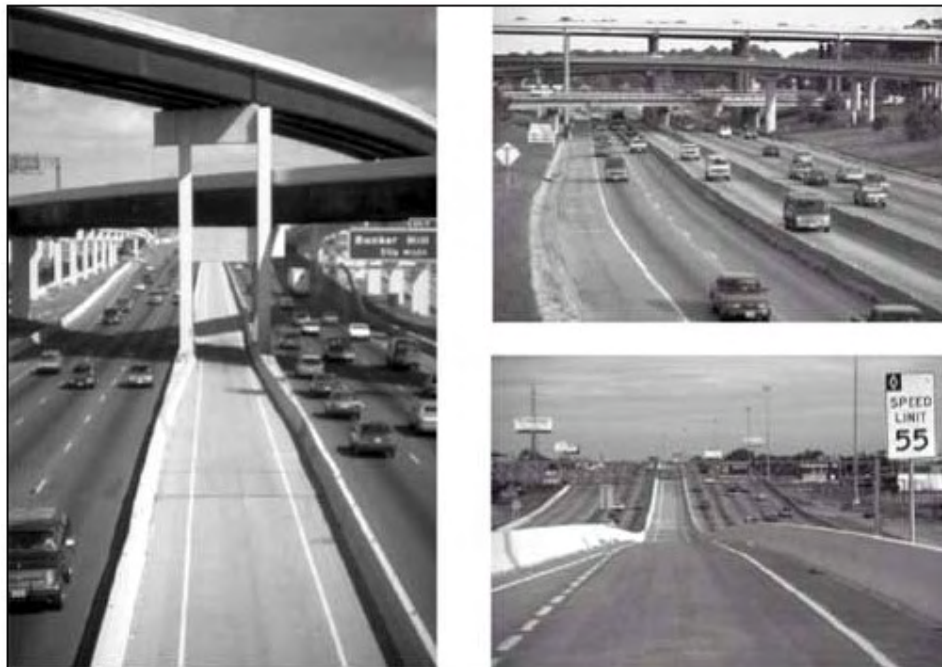
Σχήμα 3.24: Διαχωρισμένες λωρίδες για οχήματα υψηλής πληρότητας (Πηγή: FHWA, 2003)
