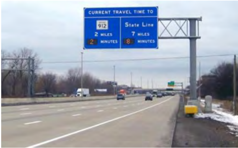
Σχήμα 3.33: Πινακίδα ενημέρωσης οδηγών σχετικά με τον χρόνο ταξιδιού, Ινδιάνα, ΗΠΑ (Πηγή: «ΔΟΕΚ», Πανεπιστήμιο Θεσσαλίας)
