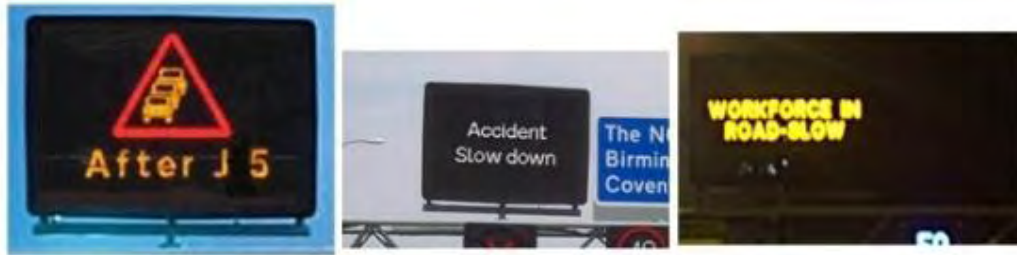
Σχήμα 3.34: Πινακίδες μεταβλητών μηνυμάτων για ενημέρωση των οδηγών σχετικά με συμφόρηση, συμβάντα και οδικές εργασίες (Πηγή: «ΔΟΕΚ», Πανεπιστήμιο Θεσσαλίας)
