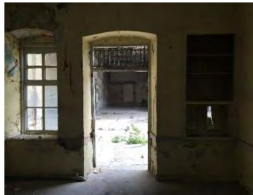
Εικόνα 10: Εσωτερικό καταστήματος της Α' φάσης κατασκευής
