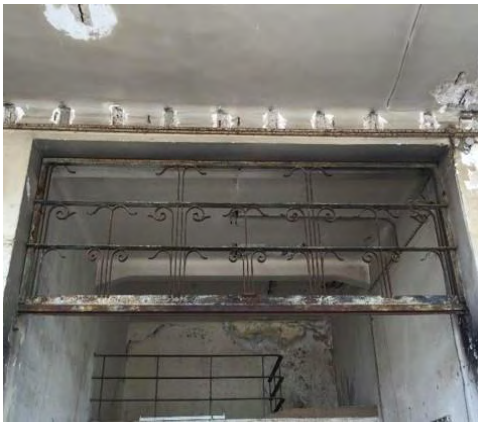
Εικόνα 13: Τα κιγκλιδώματα της Β' φάσης κατασκευής
