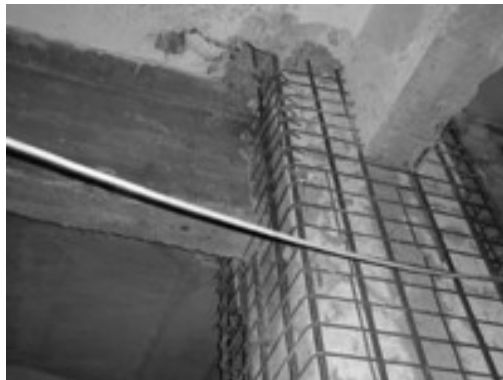
Σχήμα 2.5 – Μανδύας από οπλισμένο σκυρόδεμα σε κόμβο (Σπυράκος, 2004).
