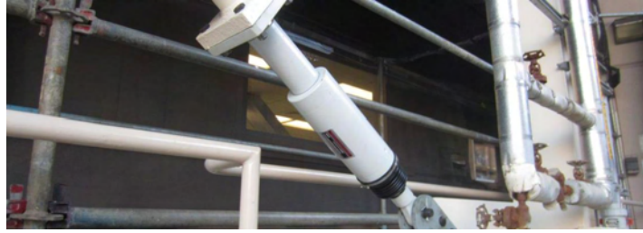
Σχήμα 2.3 – Σεισμικός αποσβεστήρας (ENKA Κατασκευαστική).
