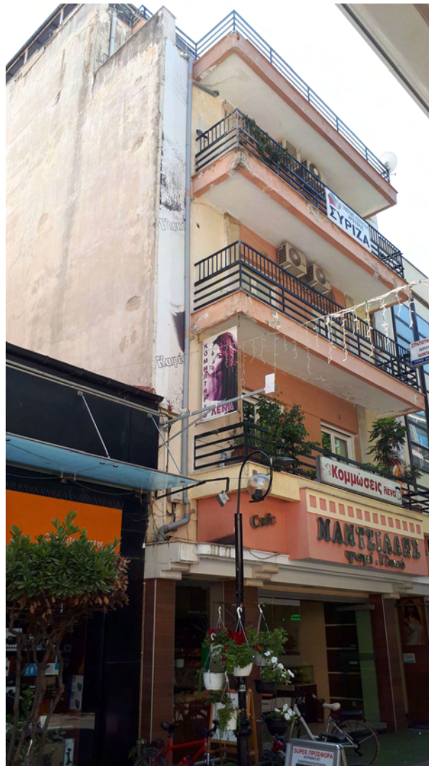
Σχήμα 3.1 – Φωτογραφία της υφιστάμενης κατασκευής.
