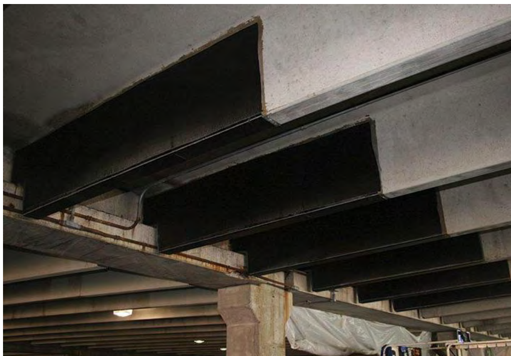
Σχήμα 1.13: Ενίσχυση δοκών με FRP (carbon fiber)
