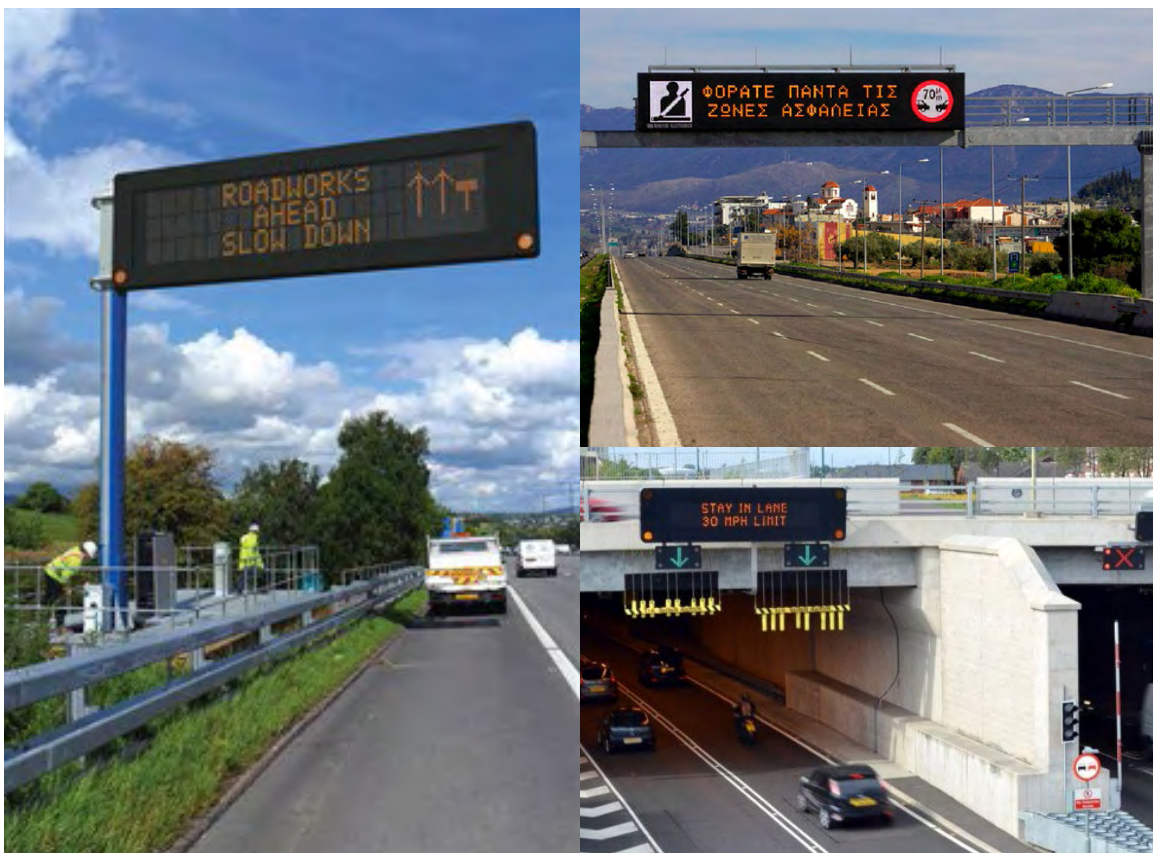
Εικόνα 1: Θέσεις τοποθέτησης των VMS (66) (67) (68)
