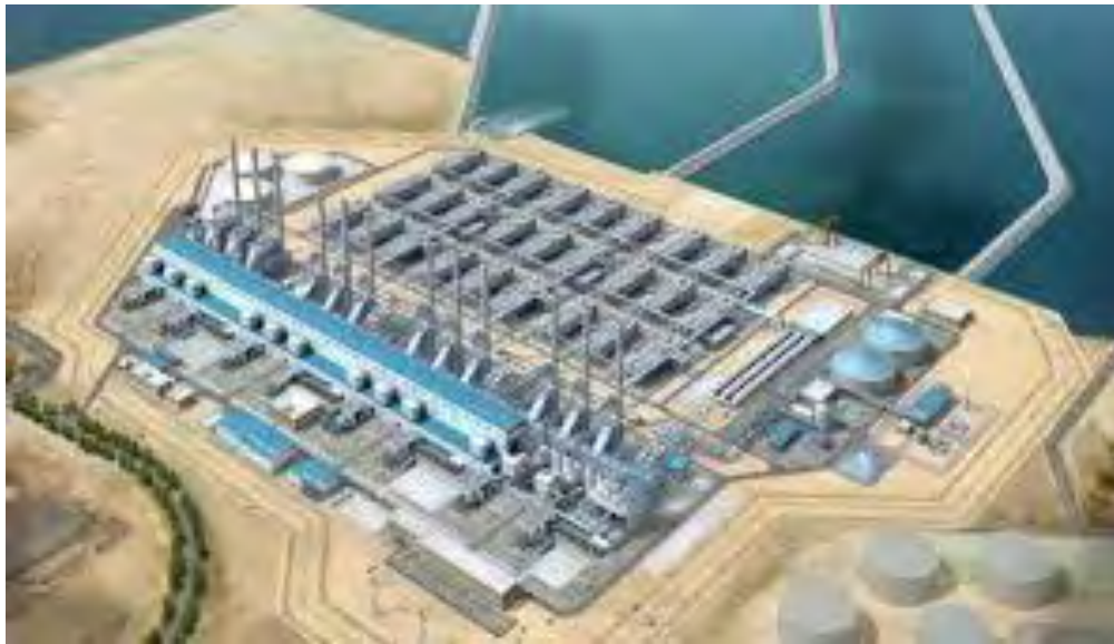
Εικόνα 7. Εναέρια απεικόνιση της μεγαλύτερης εγκατάστασης μονάδας αφαλάτωσης στον κόσμο, Ras Al-Khair, Σαουδική Αραβία ( www.aeconline.ae , 20/11/2013)
