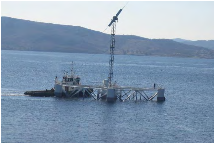
Εικόνα 15. Πλωτή μονάδα αφαλάτωσης Υδριάδα ( www.hellaskps.gr , 25/11/2013)
