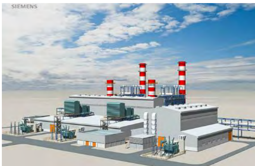
Εικόνα 6. Απεικόνιση της εγκατάστασης παραγωγής ενέργειας που θα παρέχει ενέργεια για τη θέρμανση των σωλήνων στη μονάδα της πολυβάθμιας εκτόνωσης ( www.water-technology.net , 20/11/2013)
