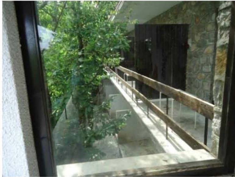
Εικόνα 64: Η σημερινή κατάσταση του Ξενία Καστανιάς
