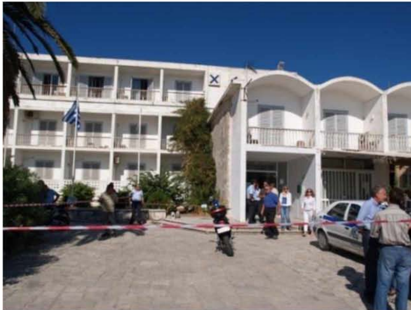
Εικόνα 68: Η σημερινή κατάσταση του Ξενία Ζακύνθου "Ανθέων"
