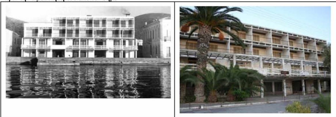
Εικόνα 72: Αριστερά απεικονίζεται το Ξενία Σάμου όταν κτίστηκε &amp; δεξιά η σημερινή του κατάσταση λίγο πριν την αξιοποίηση του από τον δήμο
