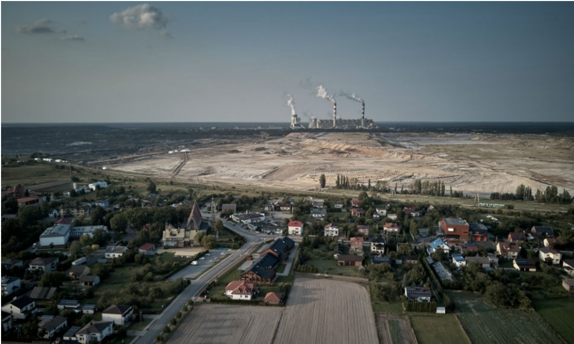
Εικόνα 10: Εξορυκτική δραστηριότητα σε απόσταση αναπνοής από οικισμό στην Πολωνία, Πηγή: https://www.clientearth.org/clientearth-lawyers-launch-court-fight-to-block-major-new-coal-mine-in-poland/
