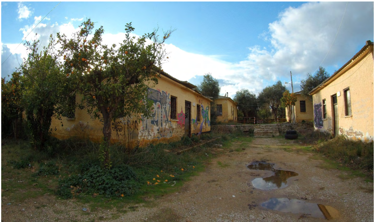
Εικόνα 23: Κτιριακό απόθεμα στρατοπέδου Δούκα
