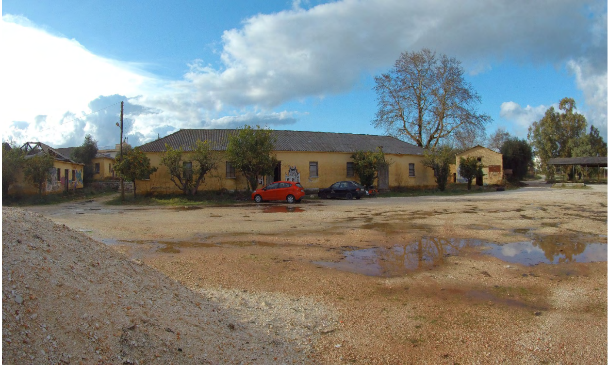
Εικόνα 22: Κτιριακό απόθεμα στρατοπέδου Δούκα
