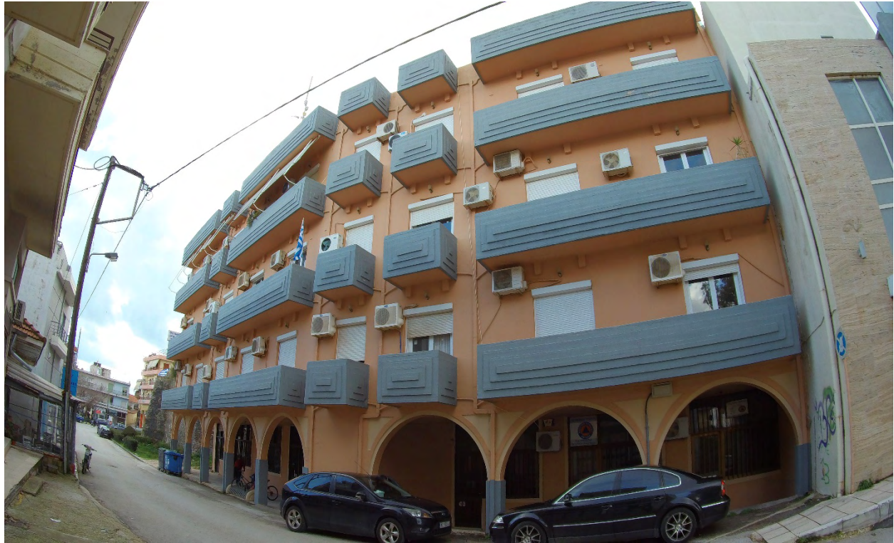
Εικόνα 16: Κτίριο πολιτιστικών υπηρεσιών
