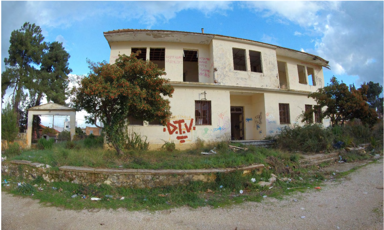
Εικόνα 20: Κτιριακό απόθεμα στρατοπέδου Δούκα
