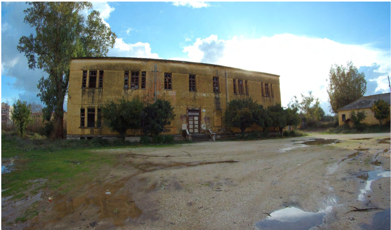
Εικόνα 21: Κτιριακό απόθεμα στρατοπέδου Δούκα
