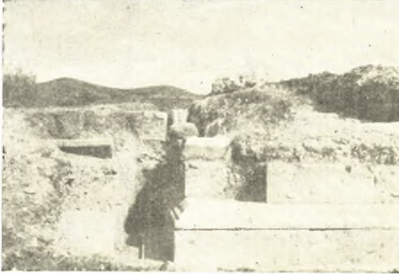
Εἰκ. 3. Νοτιοδυτικὴ γωνία τοῦ κρηπιδώματος.
