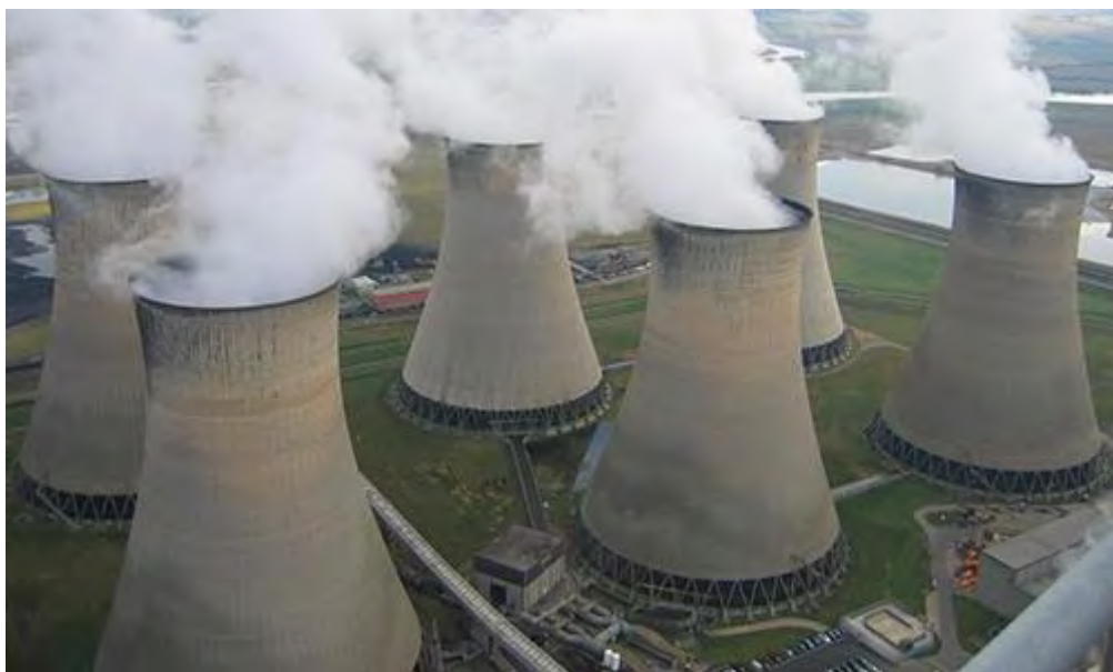
Σχήμα 3.10: Πύργοι ψύξης φυσικής κυκλοφορίας IHHH :zenithstructural.com
