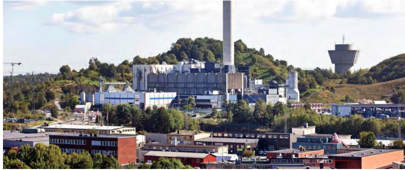
Σχήμα 4.11: Η εγκατάσταση στη Στοκχόλμη ΠΗΓΗ: www.fortum.com
