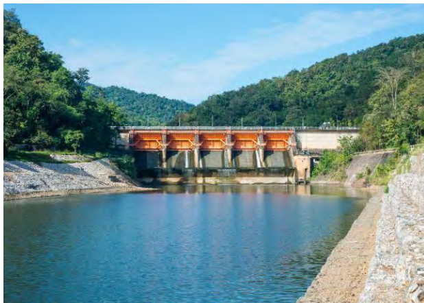
Εικόνα 3.2 Φράγμα στο Λάος που κατέρρευσε το 2018 [59]
