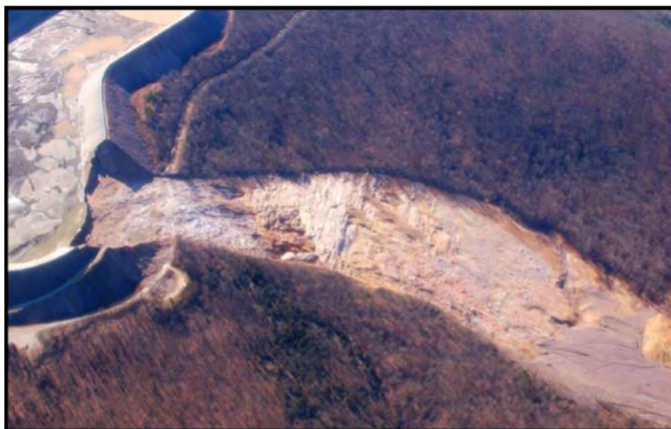
Εικόνα 3.1 Κατάρρευση φράγματος Tau Sauk [7]
