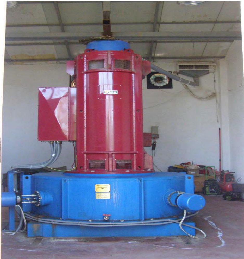
Εικόνα 7.8 Υδροστρόβιλος Pelton κάθετου άξονα
