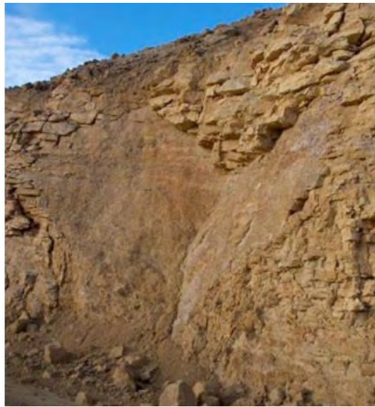
Εικόνα 3-3. Βραχώδες πρανές σε σφηνοειδή αστοχία [25].
