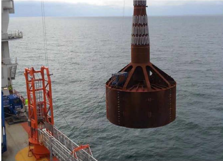
Σχήμα 3.11 Πόντιση κατασκευής με έδραση κενού/αναρροφήσεως (www.4coffshore.com)
