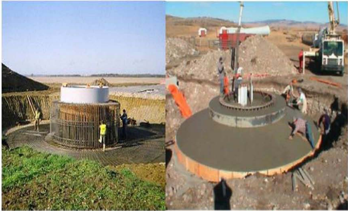
Σχήμα 3.1 Εργασίες κατασκευής επιφανειακού θεμελίου (www.buildipedia.com)
