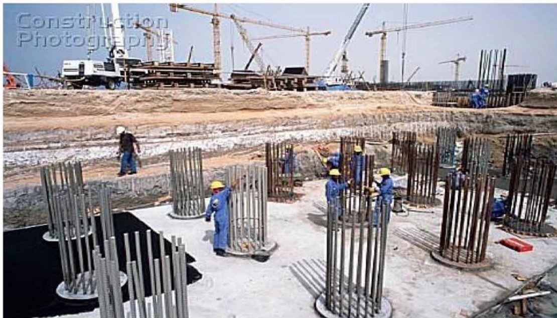
Σχήμα 3.4 Εργασίες κατασκευής πασσάλων (www.civiltoday.com)
