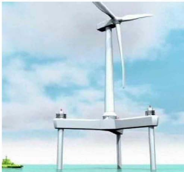
Σχήμα 3.9 Τριπλός πυλώνας (triple pile) (www.4coffshore.com)
