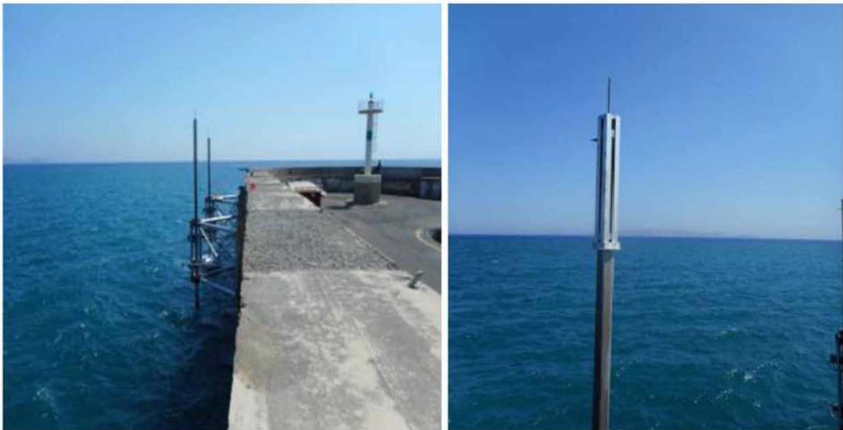
Εικόνα 40: Οι δύο μετατροπείς κυματικής ενέργειας στο λιμενοβραχίονα του Ηρακλείου Κρήτης. (Πηγή: https://energypress.gr )
