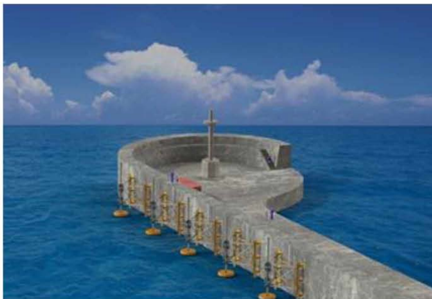
Εικόνα 41: Προοπτική άποψη των πέντε κυματικών μετατροπών στο λιμενοβραχίονα του Ηρακλείου Κρήτης. (Πηγή: https://www.sinnpower.com )
