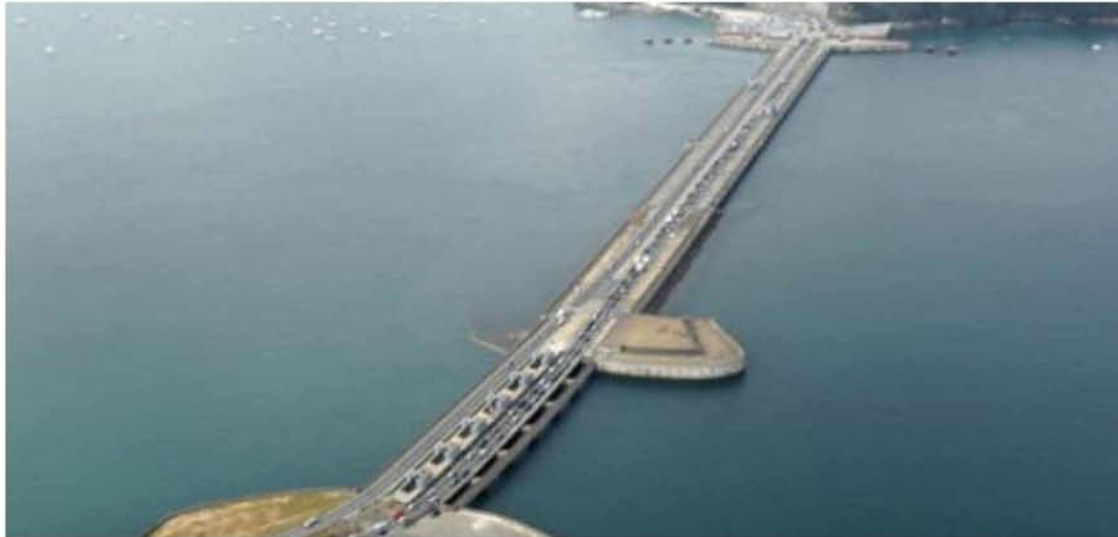
Εικόνα 16: Σταθμός παραγωγής ηλεκτρικής ενέργειας La Rance, Γαλλία. (Πηγή: https://theecologist.org/2010/nov/10/how-france-eclipsed-uk-brittany-tidal-success-story )
