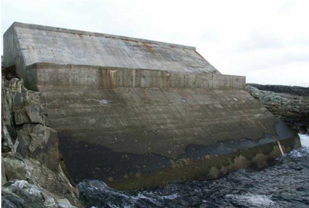
Εικόνα 44: Σταθερή συσκευή OWC – Islay Limpet. (Πηγή : https://en.wikipedia.org/wiki/Islay_LIMPET )
