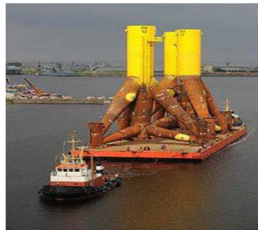
Εικόνα 5 : α) Κατασκευές διαφόρων τύπων θεμελίωσης για υπεράκτιες ανεμογεννήτριες σε ένα λιμάνι, (β) Κατασκευές θεμελίωσης τύπου Tripod για υπεράκτιο αιολικό πάρκο το 2008 στο Wilhelmshaven, Γερμανία. (Πηγή:
