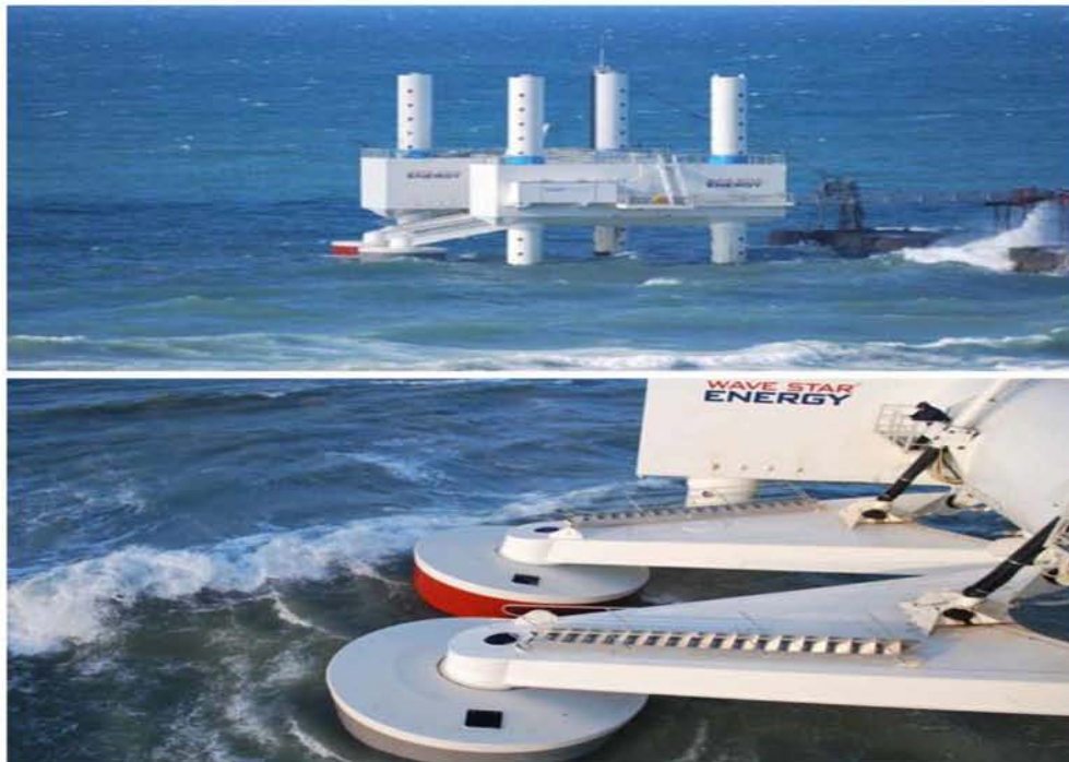
Εικόνα 31: Σύστημα μετατροπής κυματικής ενέργειας Wave Star. (Πηγή: www.wavestarenergy.com )
