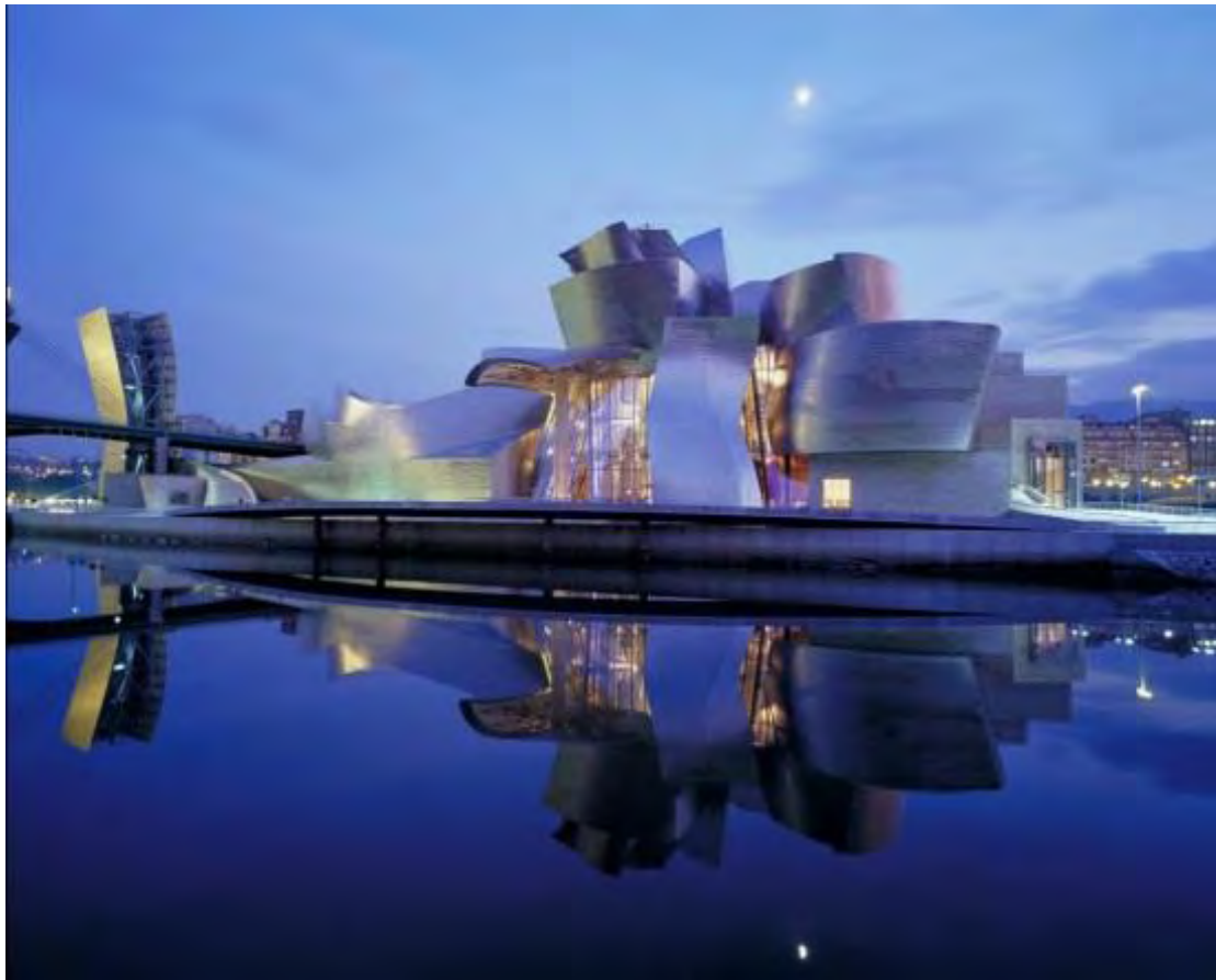
Εικόνα 7: Μουσείο Guggenheim στο Bilbao
