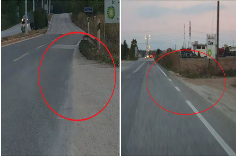
Απότομη διατομή Gutter στο έρεισμα
