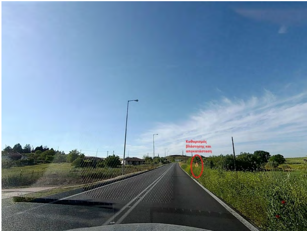
ΧΘ 8+700: Παρόδια πρόσβαση με ελλιπής ορατότητα και συνεχή οριζόντια διαγράμμιση.
