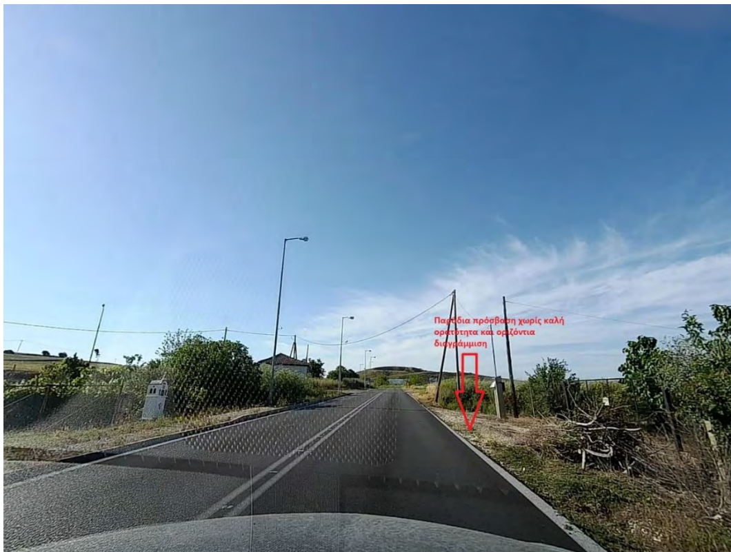
ΧΘ 8+700: Παρόδια πρόσβαση με ελλιπής ορατότητα και συνεχή οριζόντια διαγράμμιση.
