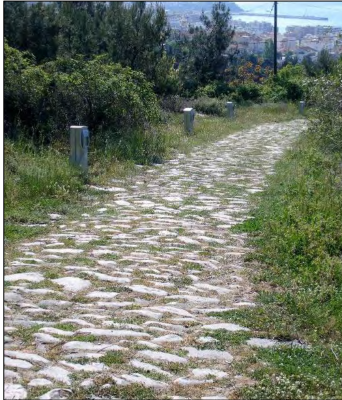
Εικόνα 2.1 Τμήμα της Αρχαίας Εγνατίας οδού στην Καβάλα [5]
