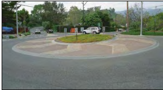
Εικόνα 5.28 Ειδική επίστρωση υπερβατής ζώνης με σχηματισμό βελών [24]
