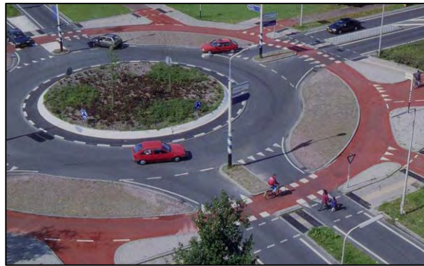
Εικόνα 4.7 Διάταξη ποδηλατοδρόμου σε κυκλικό κόμβο [40]
