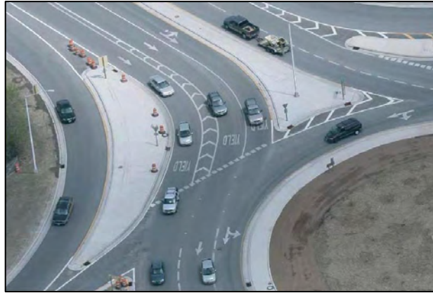
Εικόνα 5.18 Παράδειγμα διαμόρφωσης διαχωριστικής νησίδας με διαγράμμιση του οδοστρώματος, για διέλευση μεγάλων φορτηγών [24]
