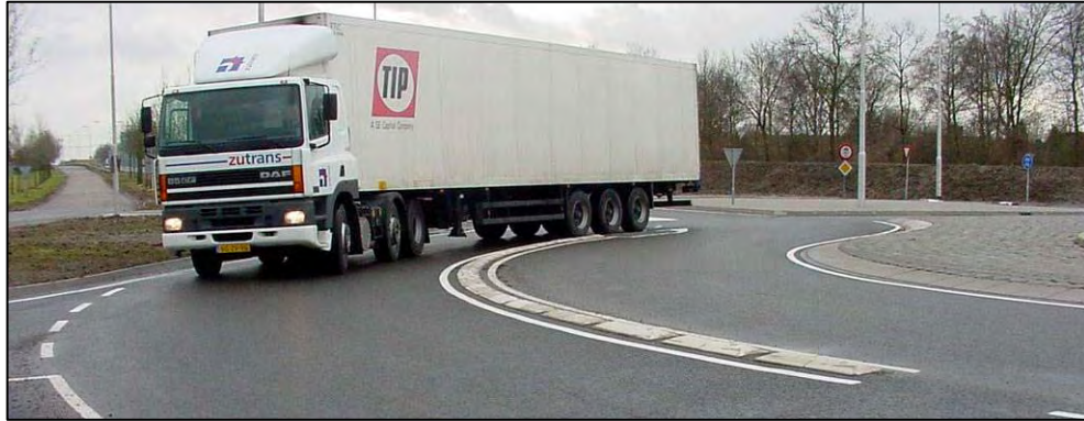
Εικόνα 3.23 Υπερυψωμένο διαχωριστικό λωρίδων (Raised mountable lane divider) σε σπειροειδή K^3 [34]
