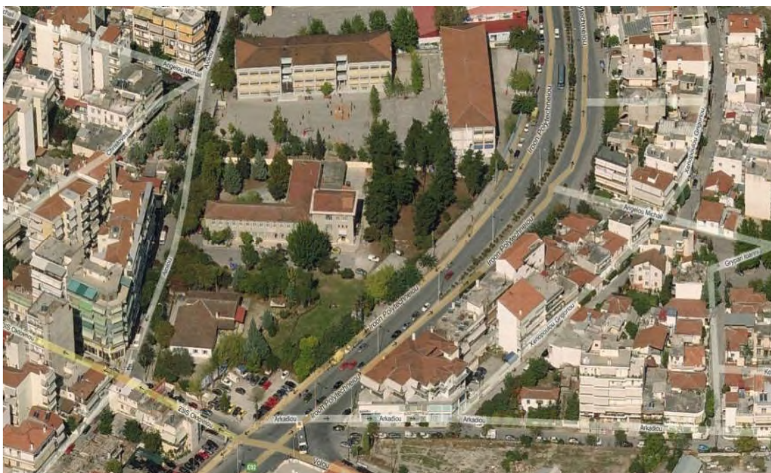
Εικόνα 7.6 1: Άποψη του κτιριακού συγκροτήματος
