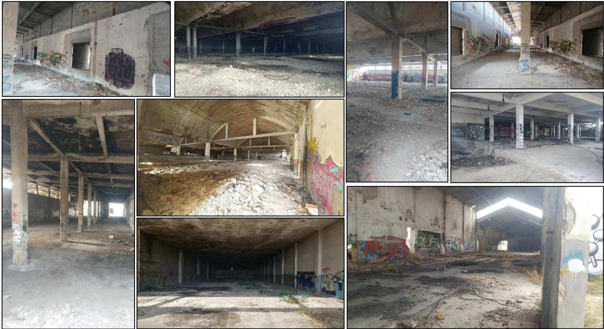
Εικόνα 4.14: Εσωτερικά κελύφη «Βαμβακουργίας». Πηγή: προσωπικό αρχείο
