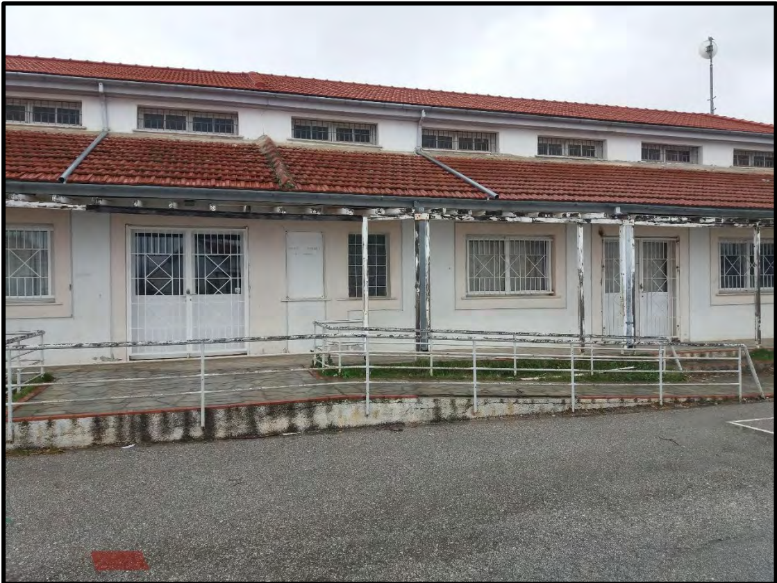
Εικόνα 8 Παράδειγμα εξωτερικής ράμπας σε σχολικό κτήριο
