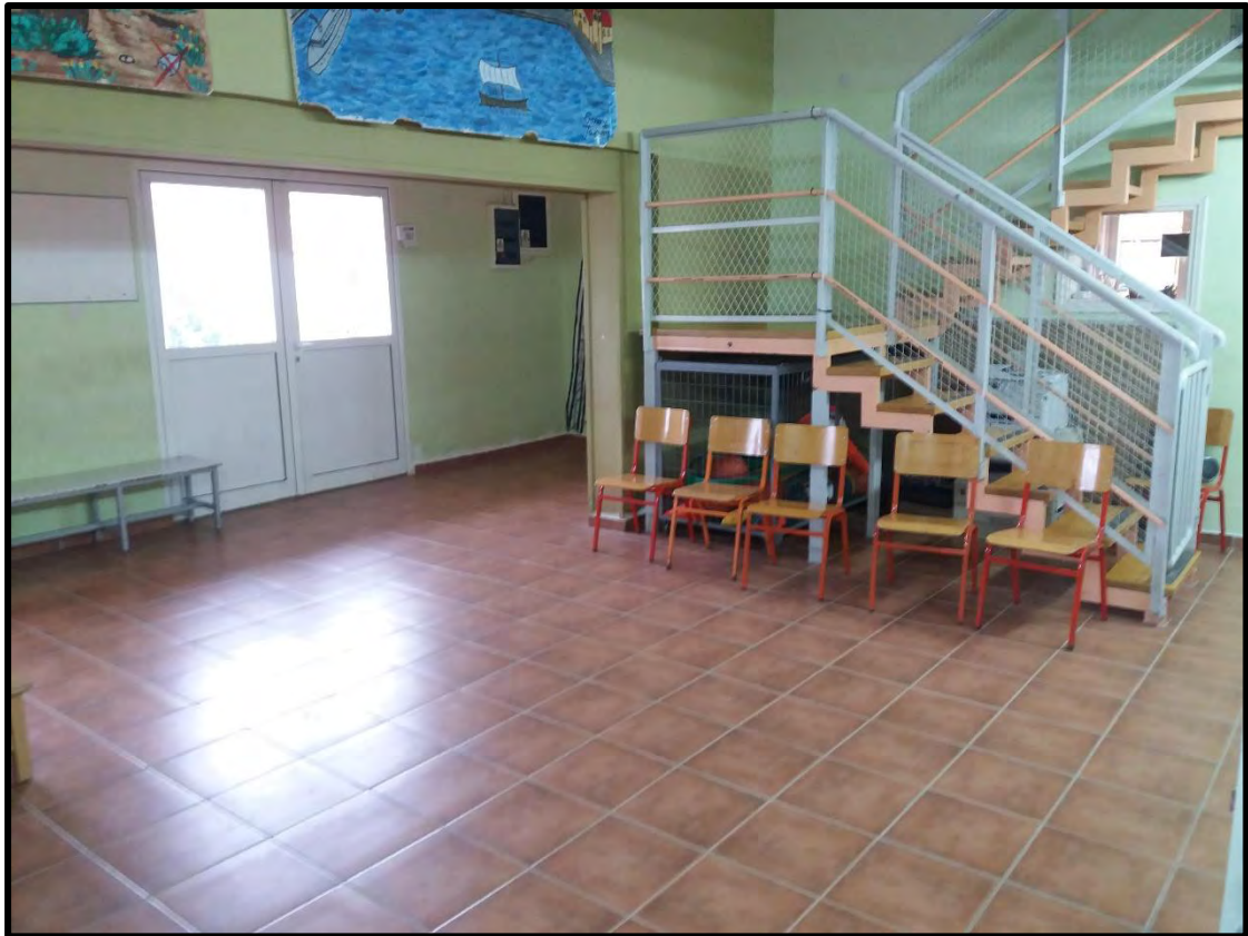
Εικόνα 7 Παράδειγμα σκάλας στον εσωτερικό χώρο σχολείου
