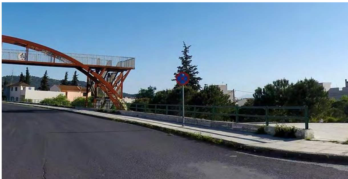
Εικόνα 3.1-51: Πεζοδρόμο με κιγκλίδωμα πίσω από αυτό στο ρεύμα προς Γορίτσα.
