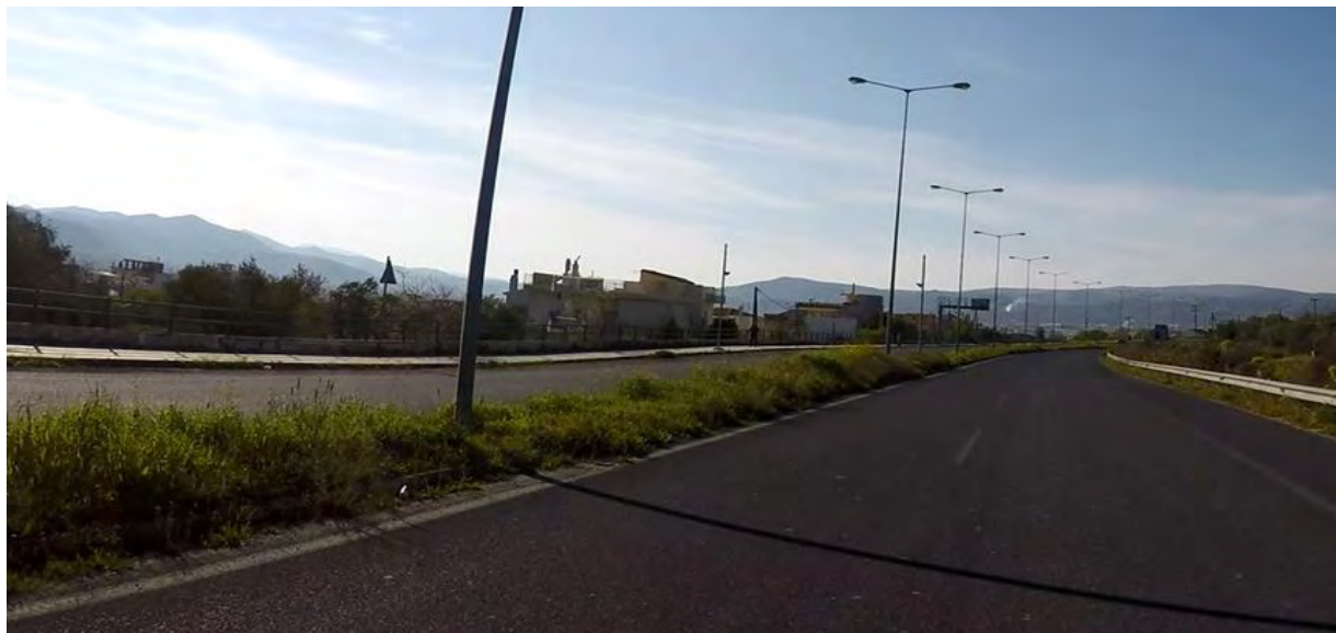
Εικόνα 3.1-28: Μείωση ορατότητας λόγω φυτοκάλυψης της οδού η οποία εισέρχεται και στο οδόστρωμα στη χιλιομετρική θέση 8+220 στο τμήμα προς Λαρίσης.
