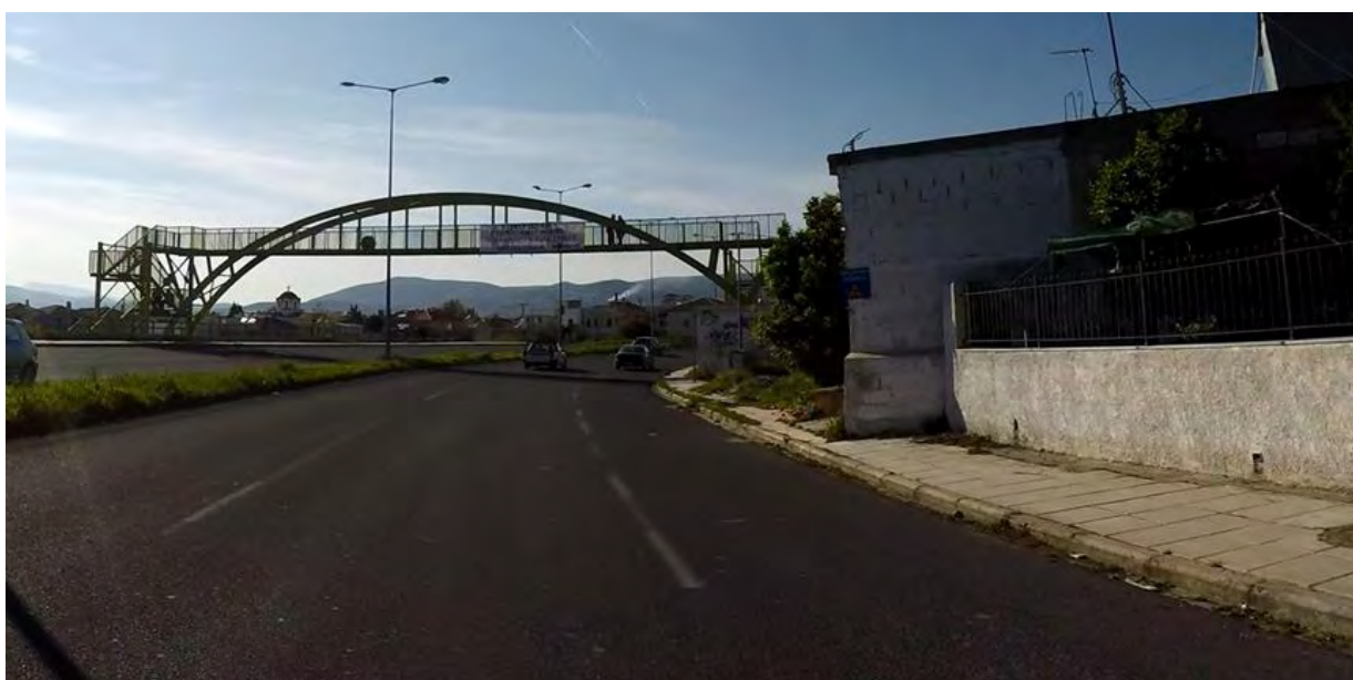
Εικόνα 3.1-47: Εξαιρετικά επικίνδυνη θέση όπου κτήριο βρίσκεται πολύ κοντά στην οριογραμμή στη χιλιομετρική θέση 6+095 στο ρεύμα προς Λαρίση.
