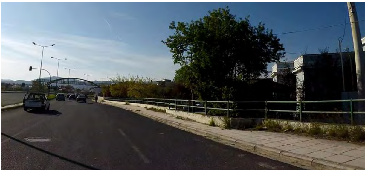
Εικόνα 3.1-46: Επικίνδυνη διαμόρφωση κυκλοδότησης στη χιλιομετρική θέση 6+166 στο ρεύμα προς Λαρίση.
