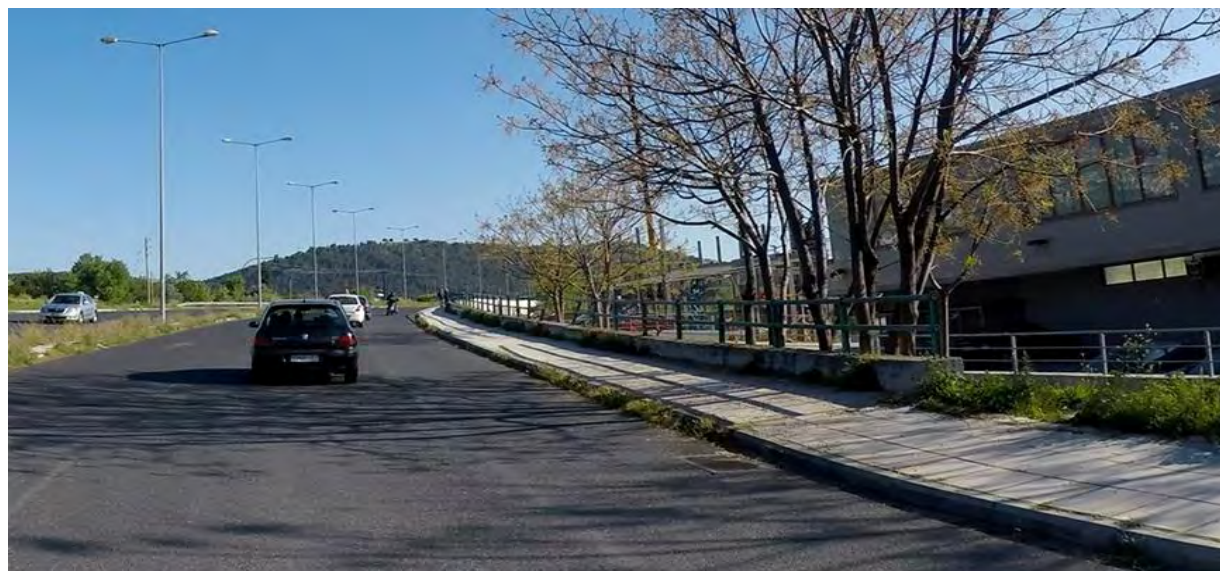
Εικόνα 3.1-52: Πεζοδρόμο με κιγκλίδωμα πίσω από αυτό στο ρεύμα προς Γορίτσα.
