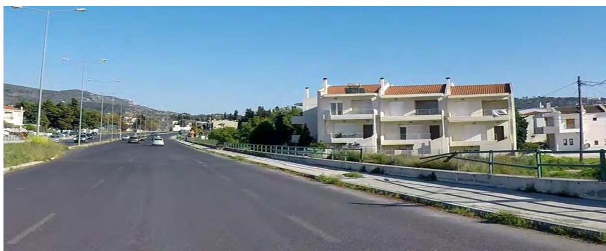
Εικόνα 3.1-56: Κιγκλίδωμα που έχει χάσει την λειτουργικότητά του στη χιλιομετρική θέση 6+780 στο ρεύμα προς Γορίτσα.
