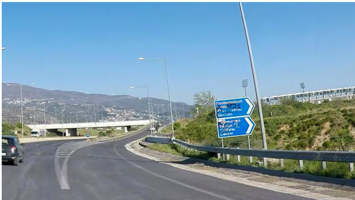
Εικόνα 3.1-33: Μη ενανάγνωστη πινακίδα σήμανσης λόγω εξωτερικής αλλοίωσης στη χιλιομετρική θέση 2+837 στο ρεύμα προς Γορίτσα.
