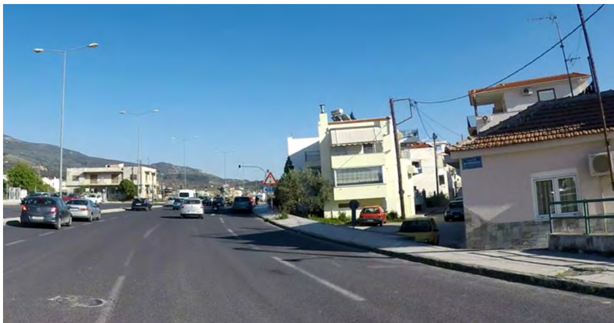
Εικόνα 3.1-43: Επικίνδυνη θέση χωρίς στηθαίο ασφαλείας στη χιλιομετρική θέση 6+169 στο ρεύμα προς Γορίτσα.
