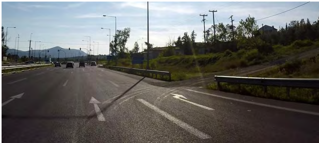
Εικόνα 3.1-19: Σύνδεση παράπλευρης οδού χωρίς τις απαραίτητες προδιαγραφές στη χιλιομετρική θέση 1+915.
