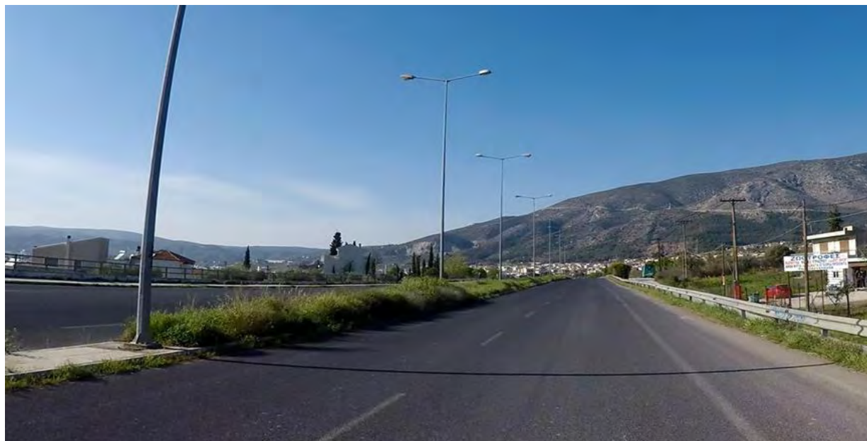
Εικόνα 3.1-29: Μείωση ορατότητας λόγω φυτοκάλυψης της οδού η οποία εισέρχεται και στο οδόστρωμα στη χιλιομετρική θέση 7+650 στο τμήμα προς Λαρίσης.
