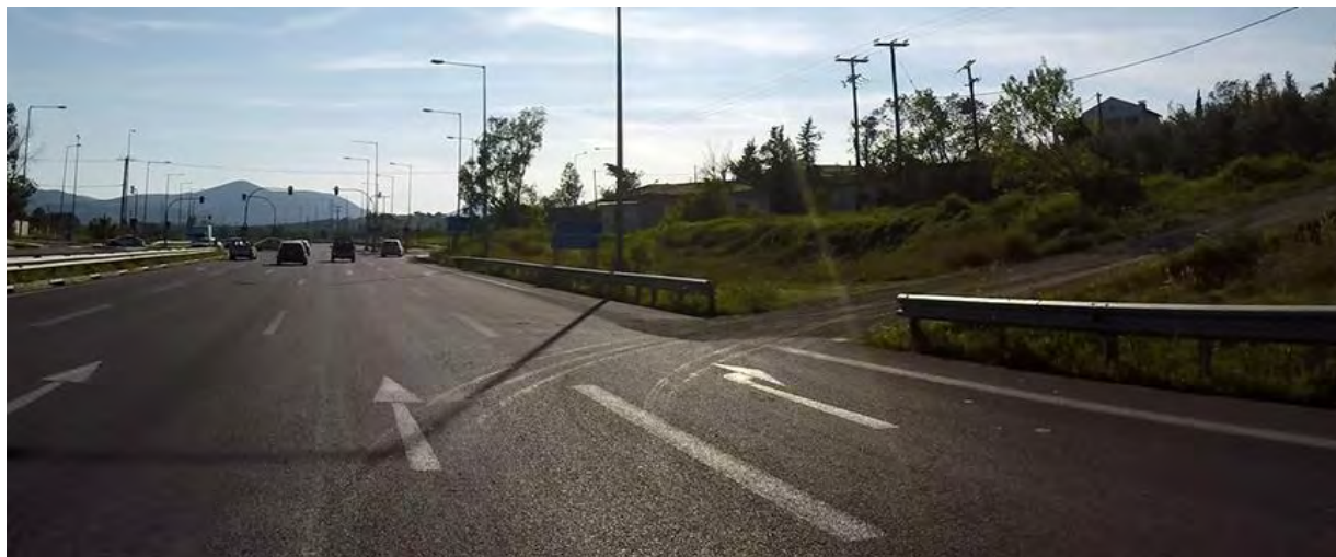
Εικόνα 3.1-62: Μη κατάλληλη διαμόρφωση απολήξεων αρχής και πέρατος.
