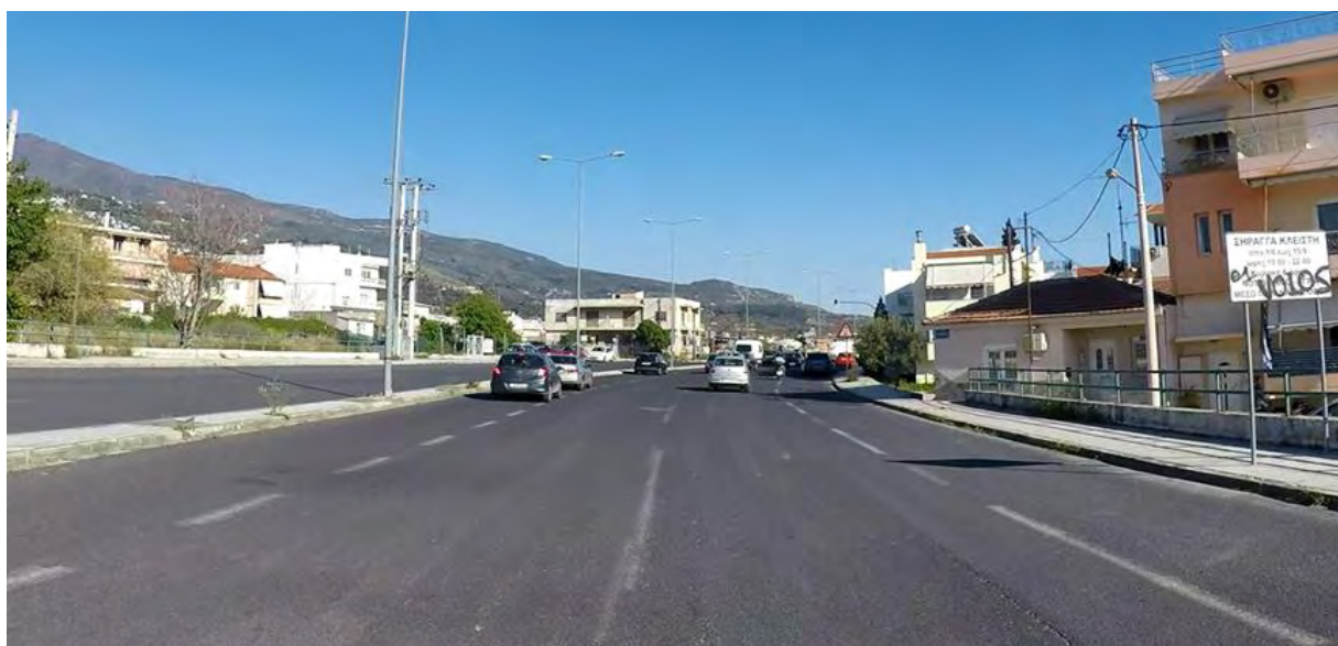
Εικόνα 3.1-35: Φθαρμένη διαγράμμιση που προκαλεί σύγχυση στους χρήστες της οδού.
