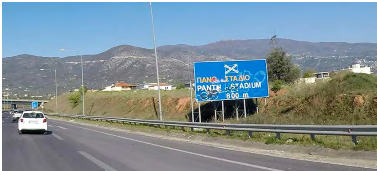
Εικόνα 3.1-32: Μη ευανάγνωστη πινακίδα σήμανσης λόγω εξωτερικής αλλοίωσης στη χιλιομετρική θέση 2+053 στο ρεύμα προς Γορίτσα.
