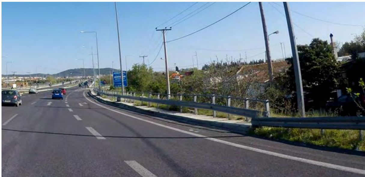
Εικόνα 3.1-58: Μη κατάλληλη διακοπή στηθαίων ασφαλείας βάσει τις ΟΜΟΕ-ΣΑΟ.
