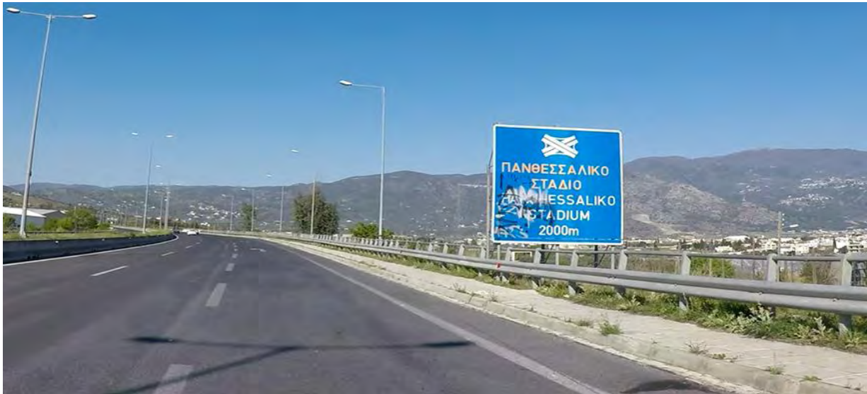
Εικόνα 3.1-31: Μη ευανάγνωστη πινακίδα σήμανσης λόγω εξωτερικής αλλοίωσης στη χιλιομετρική θέση 0+693 στο ρεύμα προς Γορίτσα.
