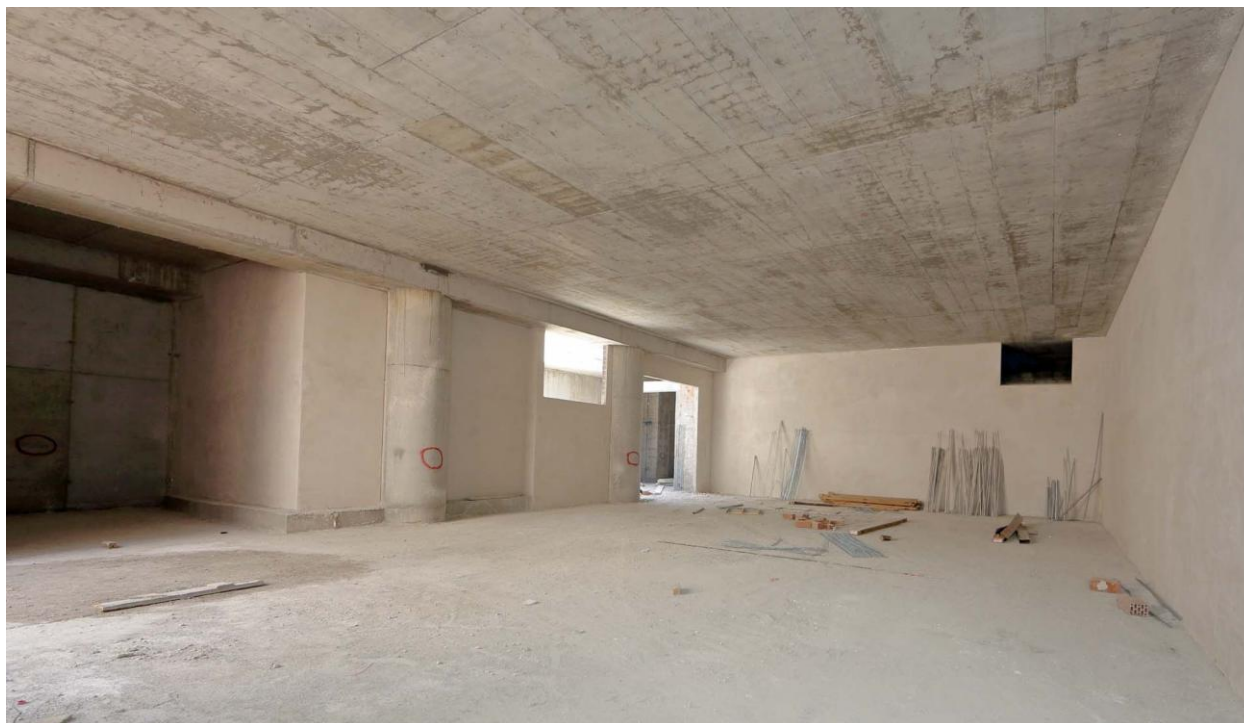
ΦΩΤΟ 4: ΑΠΟΨΗ ΕΠΙΧΡΙΣΜΑΤΩΝ ΕΠΙΠΕΔΟΥ ΜΗΧΑΝΟΛΟΓΙΚΟΥ ΟΡΟΦΟΥ - 2016
