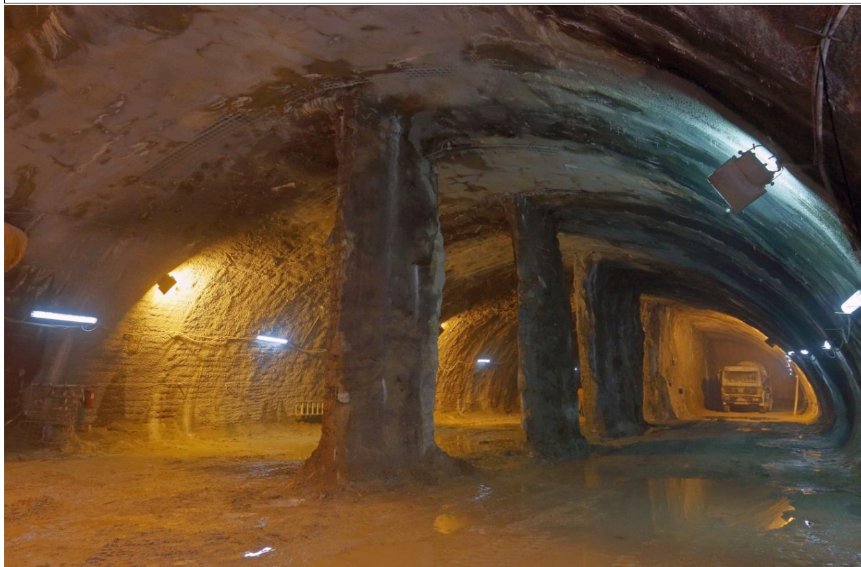
ΦΩΤΟ 21: ΚΑΘΑΙΡΕΣΗ ΜΕΣΑΙΟΥ ΤΟΙΧΩΜΑΤΟΣ ΒΟΡΕΙΑΣ ΣΗΡΑΓΓΑΣ ΣΤΑΘΜΟΥ - 2015
