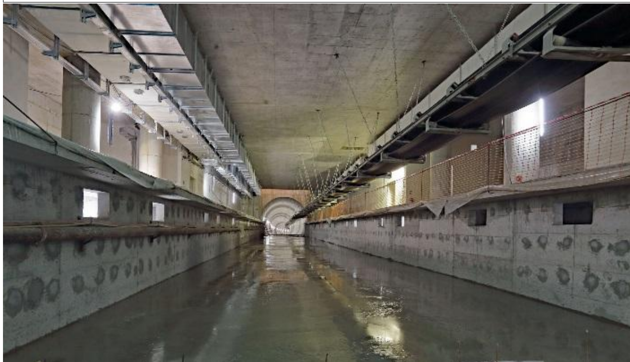
ΦΩΤΟ 5 ΣΚΥΡΟΔΕΤΗΣΗ Γ ΦΑΣΗΣ ΕΠΙΠΕΔΟΥ ΤΡΟΧΙΩΝ ΣΤΑΘΜΟΥ ΑΓ. ΒΑΡΒΑΡΑΣ – 2017
