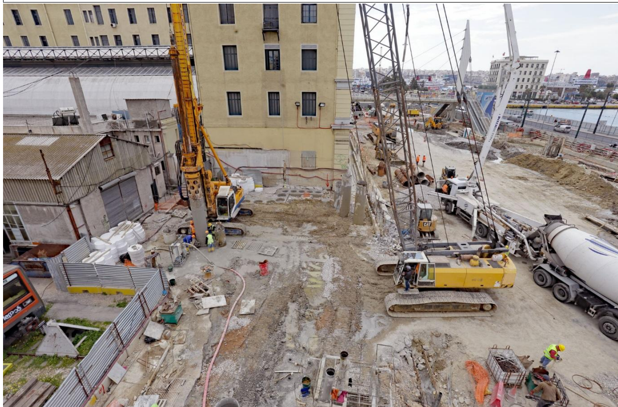
ΦΩΤΟ 27: ΚΑΤΑΣΚΕΥΗ ΠΑΣΣΑΛΩΝ ΕΙΣΟΔΟΥ Νο.3 - 2017
