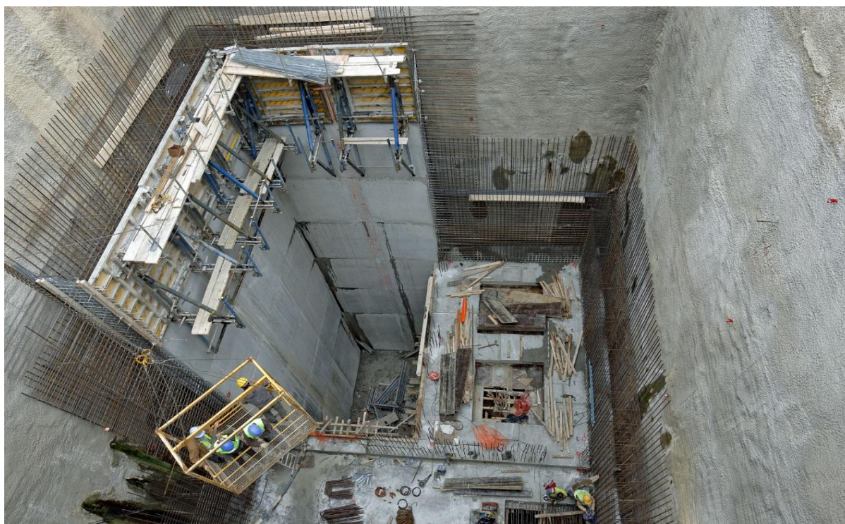
ΦΩΤΟ 40: ΚΑΤΑΣΚΕΥΗ ΕΞΩΤΕΡΙΚΩΝ ΠΕΡΙΜΕΤΡΙΚΩΝ ΤΟΙΧΩΝ ΦΡΕΑΤΟΣ - 2016
