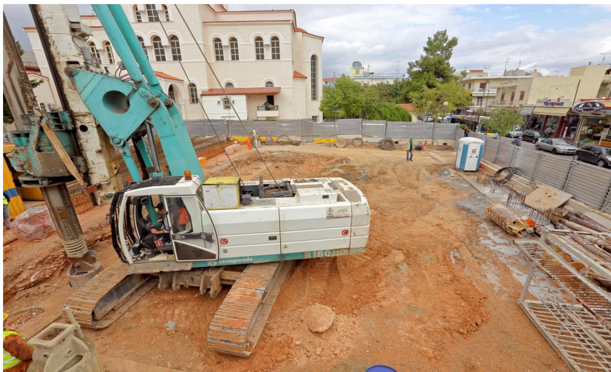
ΦΩΤΟ 39: ΔΙΑΤΡΗΣΗ ΠΑΣΣΑΛΩΝ – 2014
