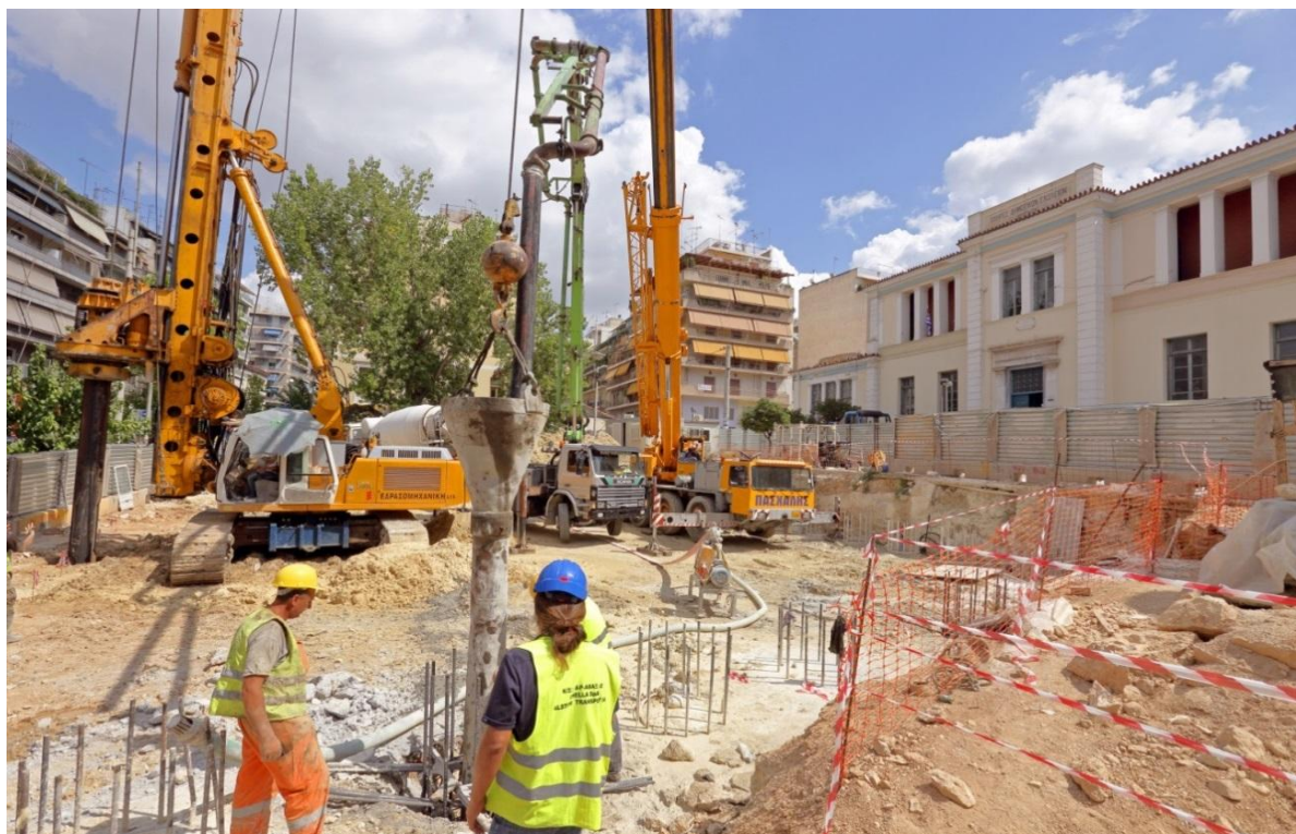
ΦΩΤΟ 37: ΕΡΓΑΣΙΕΣ ΔΙΑΤΡΗΣΗΣ ΚΑΙ ΣΚΥΡΟΔΕΤΗΣΗΣ ΠΑΣΣΑΛΩΝ - 2014
