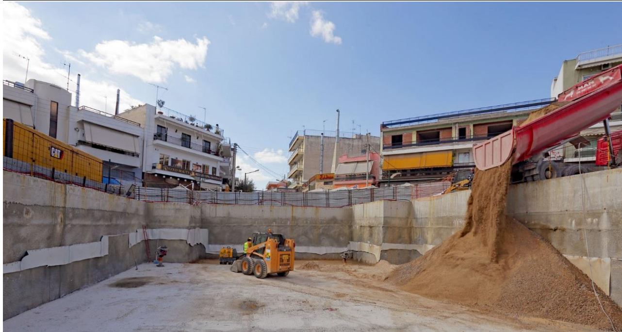
ΦΩΤΟ 11: ΕΡΓΑΣΙΕΣ ΕΠΙΧΩΣΗΣ ΠΛΑΚΑΣ ΟΡΟΦΗΣ - 2017
