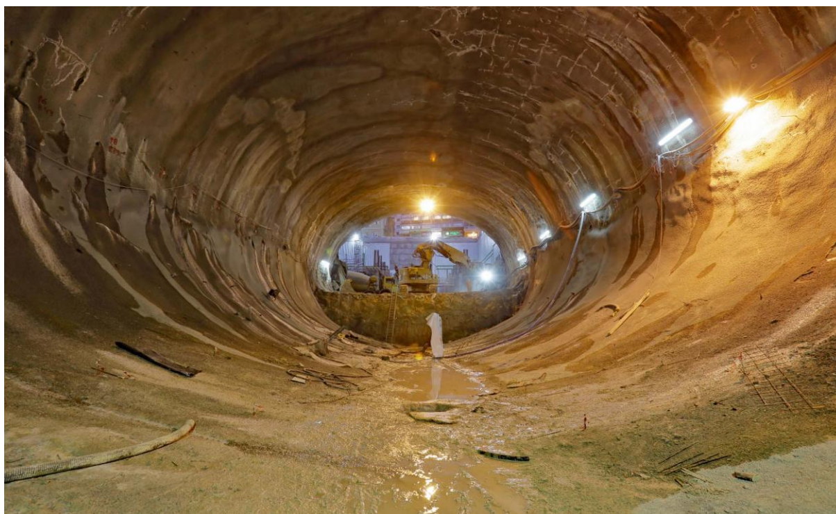
ΦΩΤΟ 32: ΑΠΟΨΗ ΒΑΣΙΚΗΣ ΣΗΡΑΓΓΑΣ NATM ΣΤΑΘΜΟΥ - 2016
