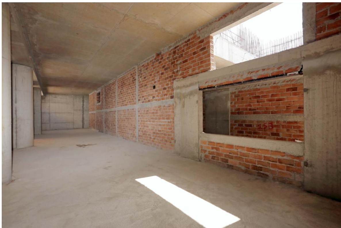
ΦΩΤΟ 16: ΑΠΟΨΗ ΕΡΓΑΣΙΩΝ ΤΟΙΧΟΠΟΙΑΣ ΣΤΑΘΜΟΥ ΕΠΙΠΕΔΟΥ ΜΗΧΑΝΟΛΟΓΙΚΟΥ ΟΡΟΦΟΥ - 2016
