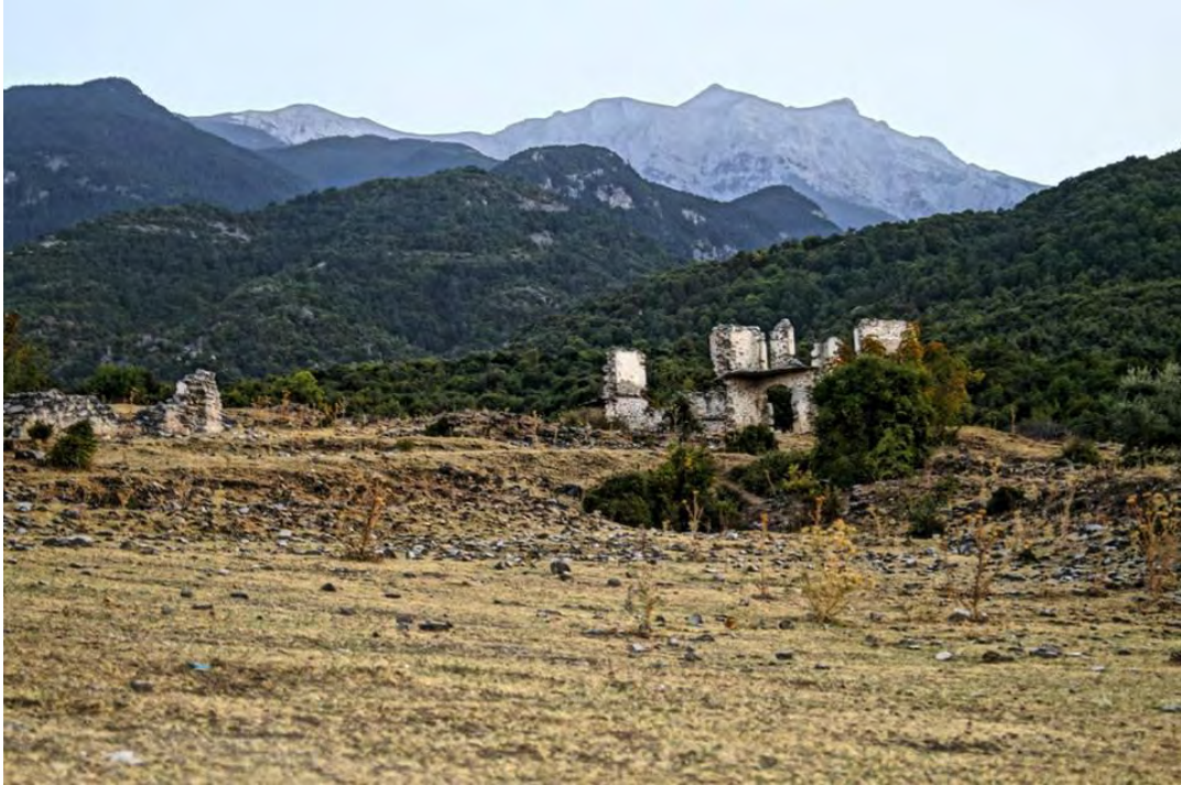
Εικόνα 17: Άποψη του ερευνημένου οικισμού "Παλαιά Βρουντού"
