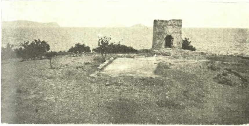
Εἰκ. 10. Τὰ ἀνευρεθέντα θεμέλια χριστιανικῆς βασιλικῆς εἰς θέσιν «ὁ μύλος τοῦ Βρούστη» ἐν Σπέτσαις.
