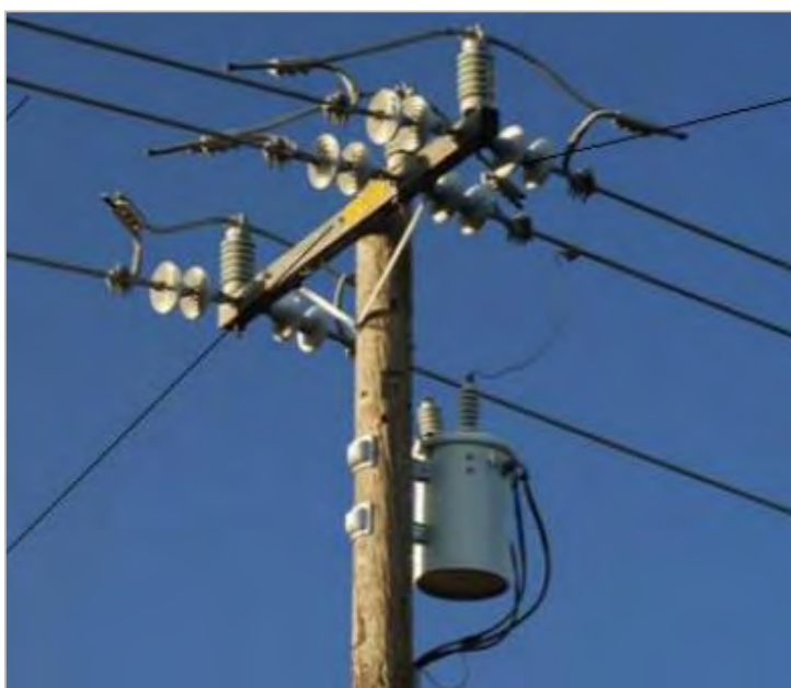
Εικόνα 2.6: Ξύλινος στύλος μέσης τάσης ΔΕΗ
