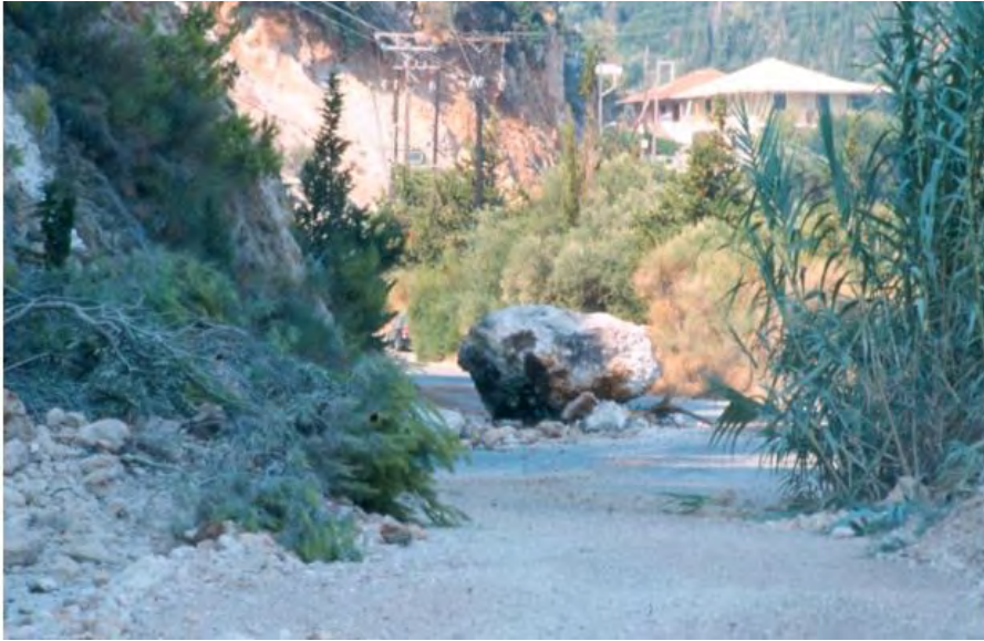
Σχήμα 3.20: Λευκάδα: κατολισθήσεις πρανών στο οδικό δίκτυο .
