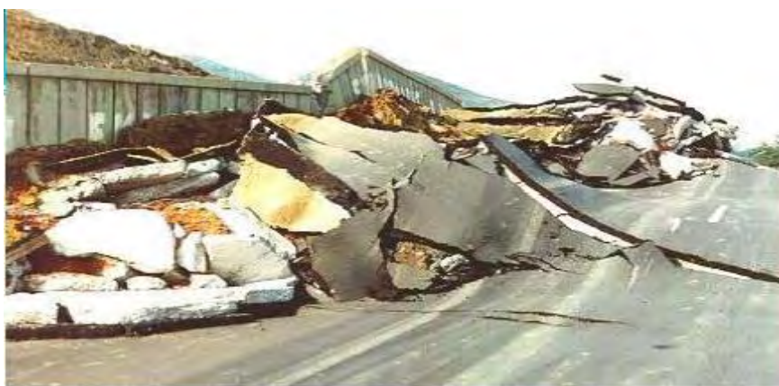
Σχήμα 3.14: Το κατεστραμμένο οδόστρωμα της Ε.Ο. Αθηνών-Θεσσαλονίκης από την κατολίσθηση της Μαλακάσας.
