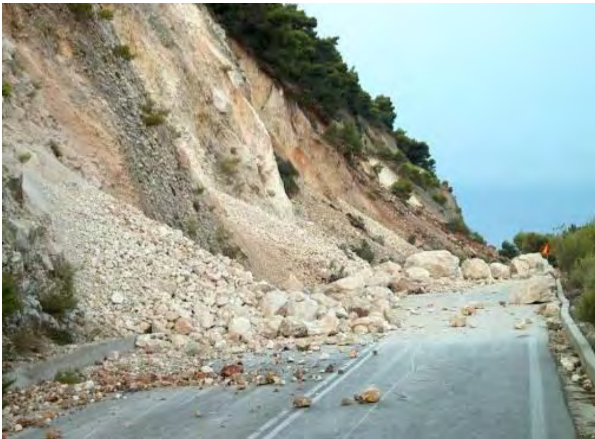
Σχήμα 3.3: Αστοχία Πρανούς και παρακώλυση κυκλοφορίας (Σεισμός Λευκάδας, 2003).
