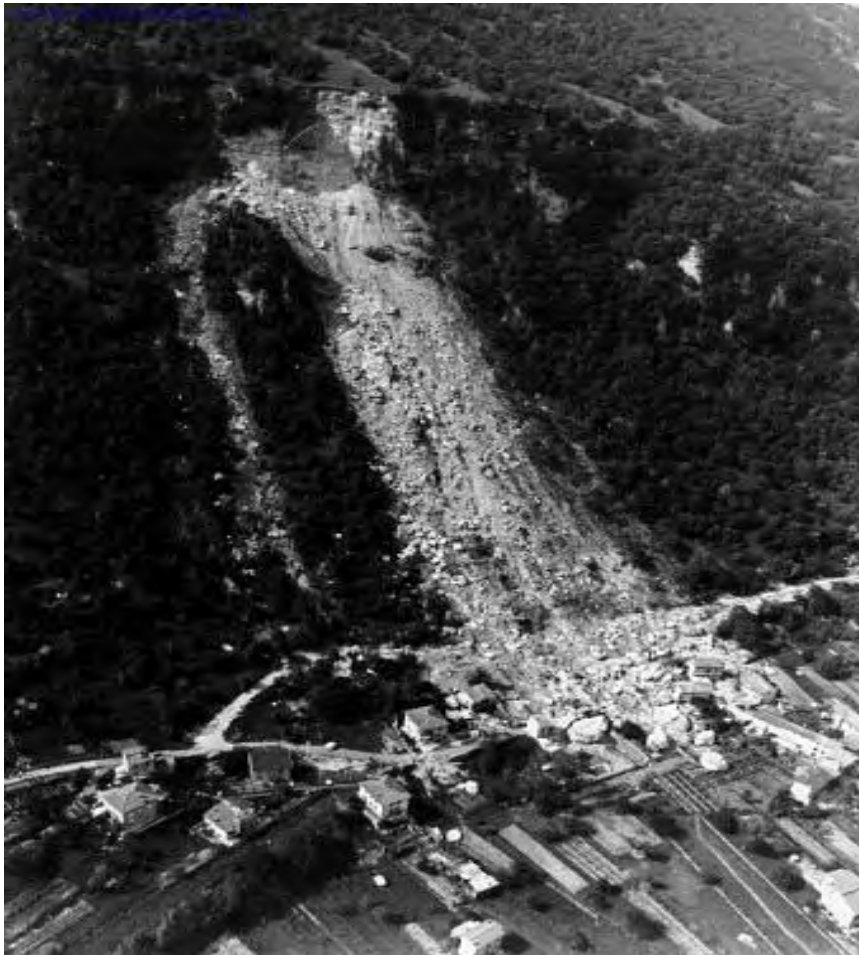
Σχήμα 3.24: Κατολίσθηση στην Gemona λόγω του σεισμού Friuli (1976).
