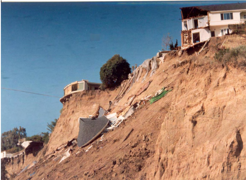
Σχήμα 3.25: Κατολίσθηση πρηνούς με κατοικίες στην πόλη Santa Monica, California, κατά τον σεισμό του Nothridge το 1994 (Ντακούλας 2004).
