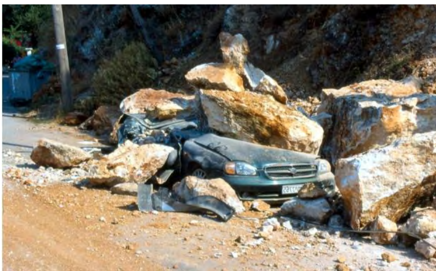
Σχήμα 3.19: Λευκάδα: κατολισθήσεις πρανών στο οδικό δίκτυο .
