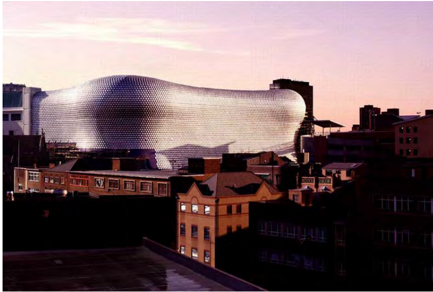
Εικόνα 10: Πρόσοψη του πολυκαταστήματος Selfridges στο Μπέρμιγγαμ των Future Systems
