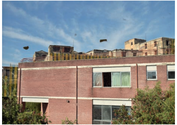
2. Οπτική τμήματος του κτιρίου από αίθουσα διδασκαλίας
