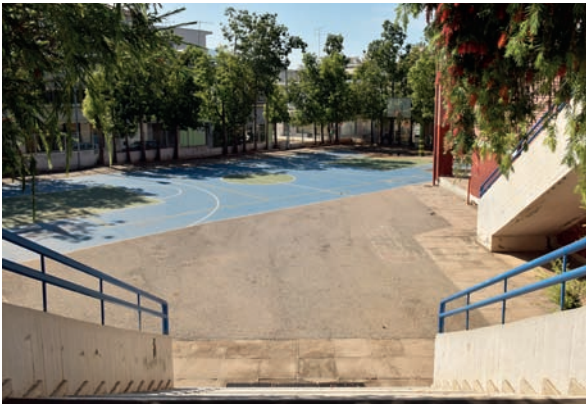
5. Σκάλα που οδηγεί στο προαύλιο από το εσωτερικό του σχολείου
