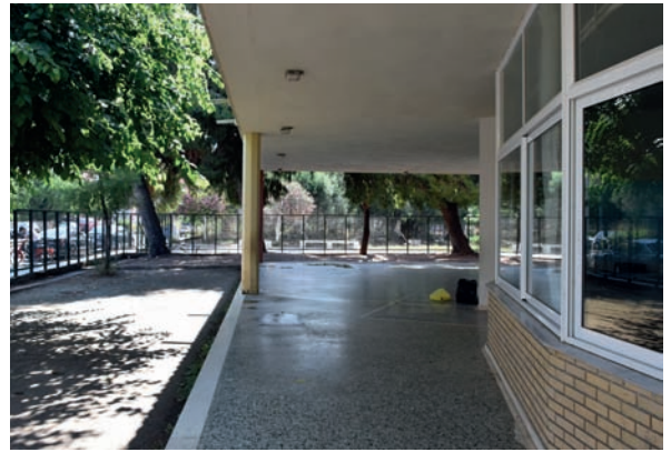
6. Στεγασμένο τμήμα του προαυλίου
