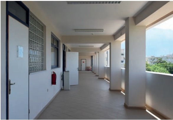
11. Εξωτερικός διάδρομος (β όροφος)
