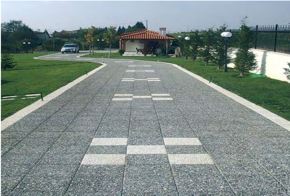
Εικόνα 42: Δρομάκι στρωμένο με ψυχρά υλικά
