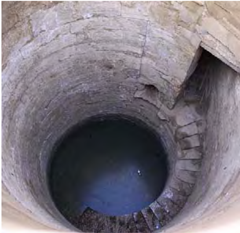
Νειλόμετρο στον ναό Kom Ombo. Η δεξαμενή επικοινωνεί με το ποτάμι και η κλίμακα επιτρέπει τον υπολογισμό της στάθμης του νερού.
