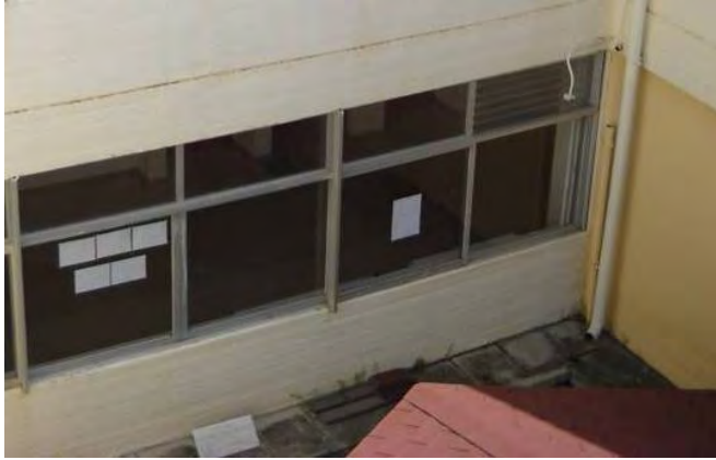
Εικόνα 4.28: Ανοίγματα διαδρόμων προς το αίθριο όπου διακρίνονται οι περσίδες στους φεγγίτες
