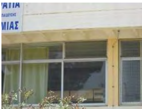
Εικόνα 4.22: Υαλοστάσιο ΒΑ όψης με περσίδες αερισμού
