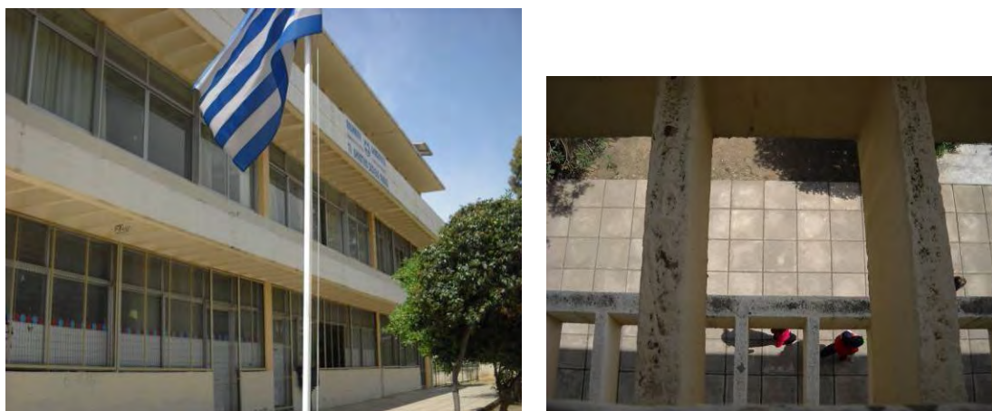
Εικόνα 4.32: Σκίαση με προστέγασμα και διάτρητους οριζόντιους προβόλους (λεπτομέρειες α,β)
