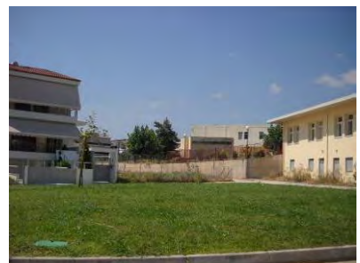
(γ) ΝΑ άποψη σχολείου,
