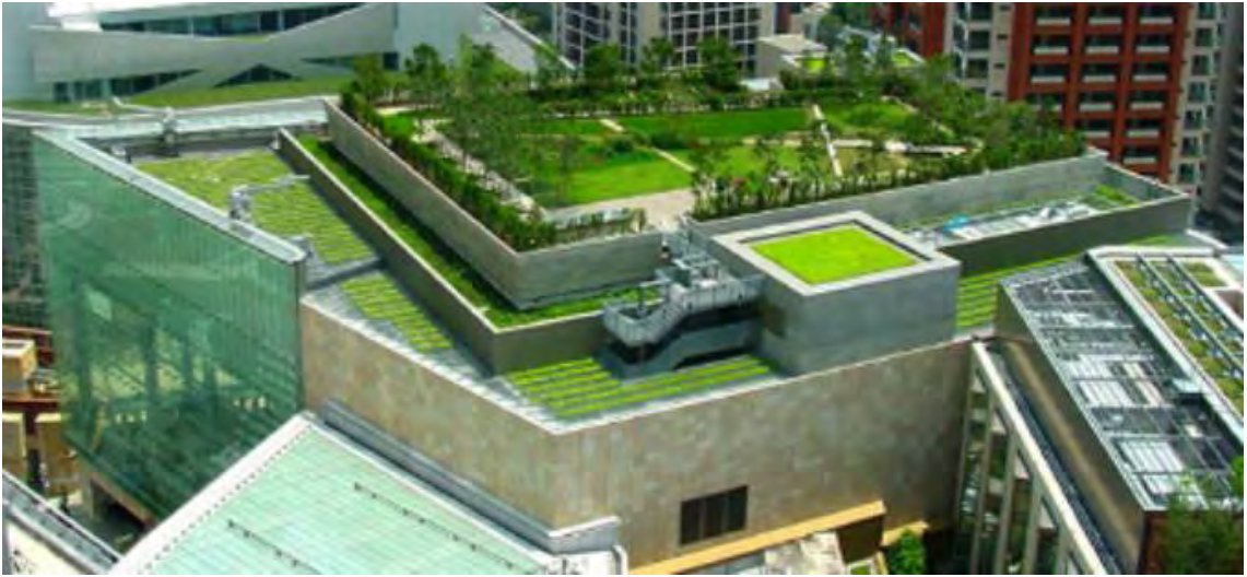
Εικόνα 2.8: Αποψη φυτεμένου δώματος, (Πηγή: http://www.google.com )
