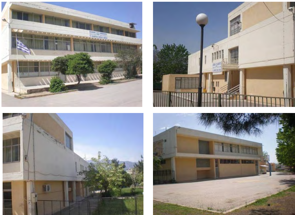
Εικόνα 4.17, Όψεις του 7 ο Δημοτικού σχολείου (Πάνω αριστερά :ΒΑ όψη-εμφανές σκυρόδεμα και συνεχή υαλοστάσια, δεξιά:ΝΑ όψη- εμφανές σκυρόδεμα και τοιχοποιία, Κάτω: αριστερά : ΒΔ όψη-εμφανές σκυρόδεμα, υαλότουβλα και τοιχοποιία, δεξιά:ΝΔ όψη- εμφανές σκυρόδεμα, υαλότουβλα και τοιχοποιία.
