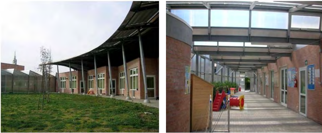
Εικόνα 3.3: Νηπιαγωγείο και Δημοτικό Σχολείο Ronzano, στο Empoli της Ιταλίας, (Πηγή: http://www.new-learn.info/packages/euleb )
