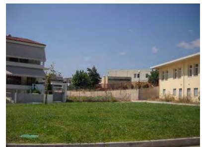
(γ) ΝΑ άποψη σχολείου,
