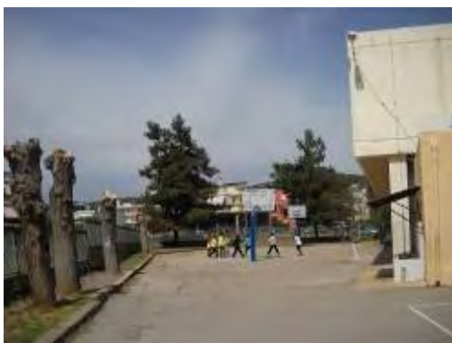
Εικόνα 4.40: Αύλειος χώρος (ΝΔ πλευρά) με τα κατεστραμμένα δέντρα
