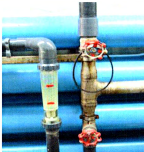
Σχήμα 4.13 Παροχόμετρο ανακυκλοφορίας.
