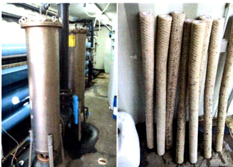
Σχήμα 4.8 Δοχεία «σχοίνινων» φίλτρων
