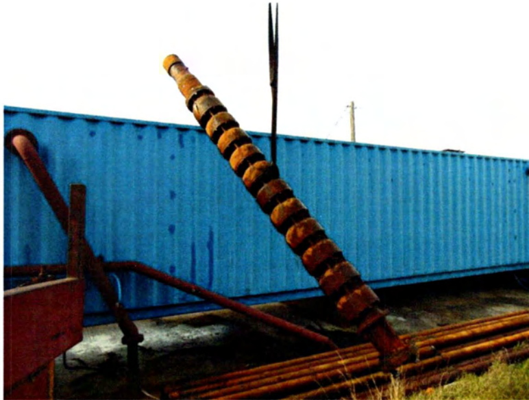
Σχήμα 4.2 Αντλία γεώτρησης υφάλμυρου νερού.
