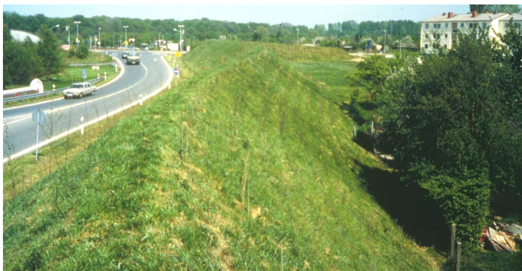
Σχήμα 3-19: Εδαφική διαμόρφωση ως αντιθορυβικό πέτασμα στη Γερμανία. Πηγή: Danish Road Institute Report 174,2009
