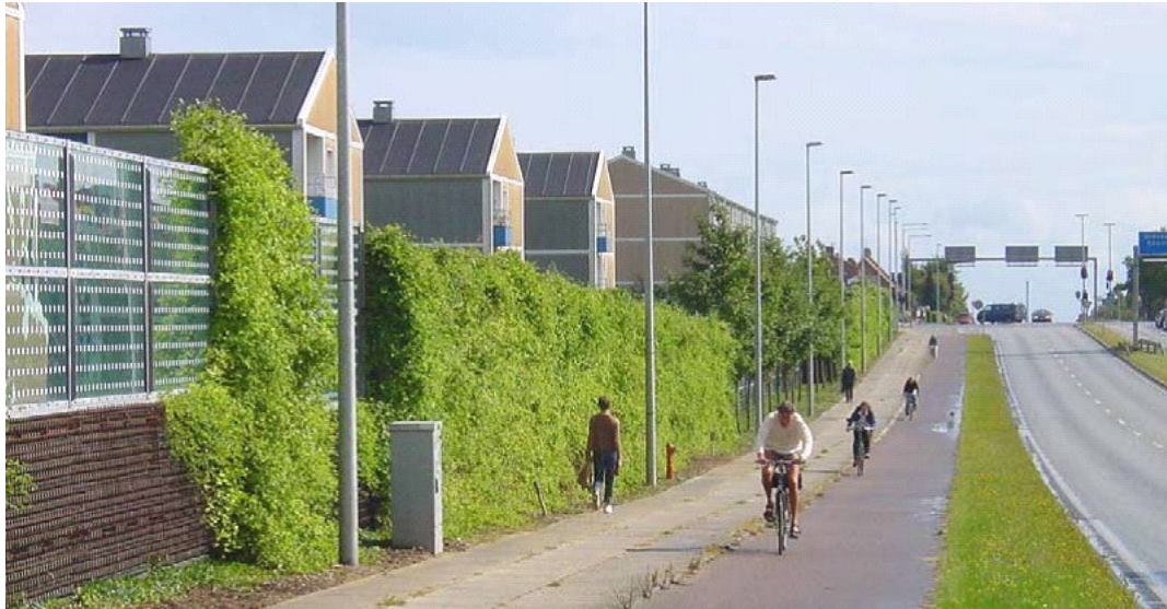
Σχήμα 3-3: Δανέζικο διαφανές πέτασμα με φύτευση που μειώνει την αντανάκλαση θορύβου Πηγή: Danish Road Institute Report 174,2009
