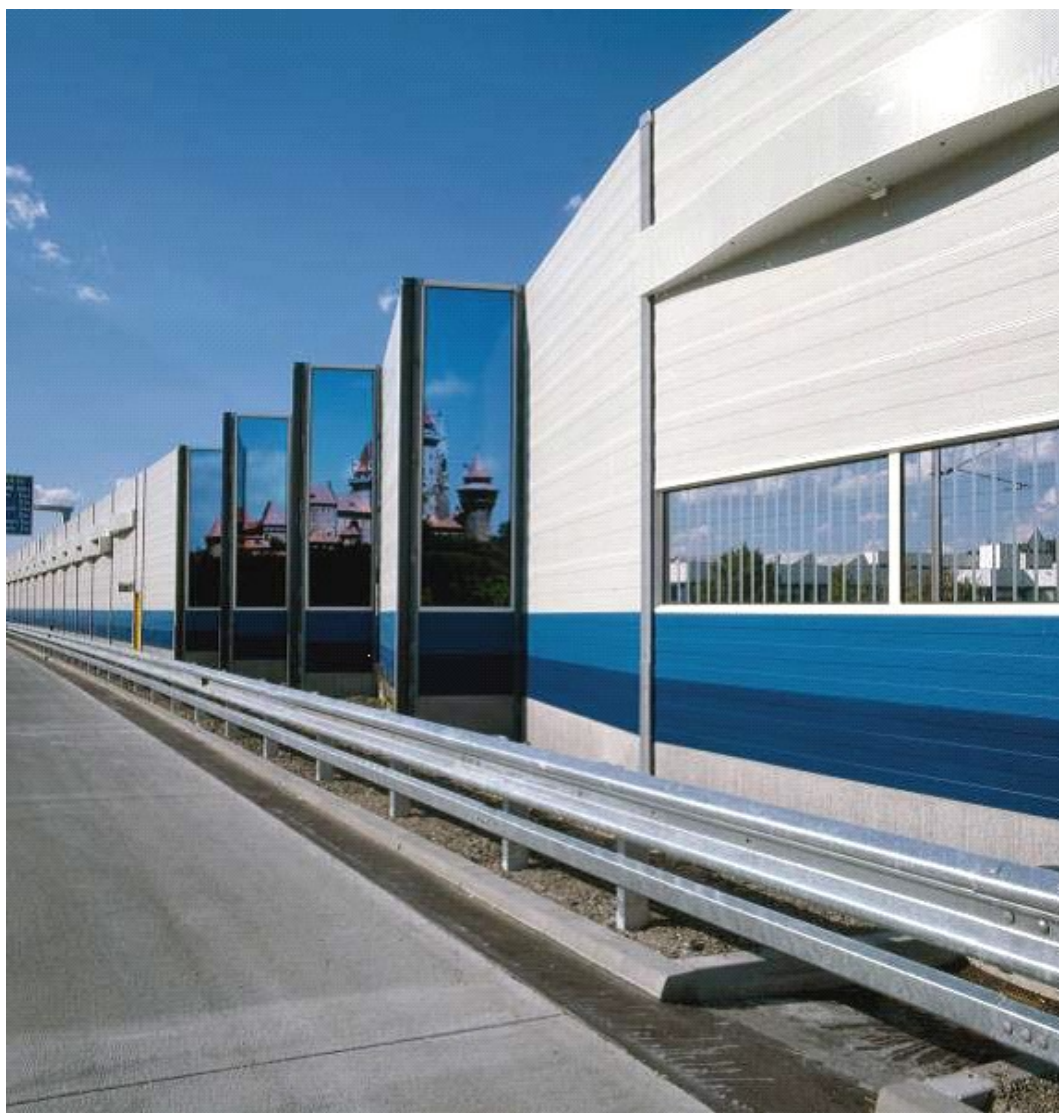
Σχήμα 3-17: Μεταλλικό με διαφανή στοιχεία αντιθρομβικό πέτασμα κατά μήκους αυτοκινητοδρόμου στη Βιέννη, Αυστρία Πηγή: Danish Road Institute Report 174,2009
