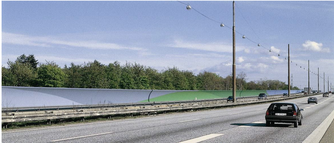
Σχήμα 3-13: Αντιθορυβικό πέτασμα από χρωματισμένο σκυρόδεμα, Κοπεγχάγη, Δανία
