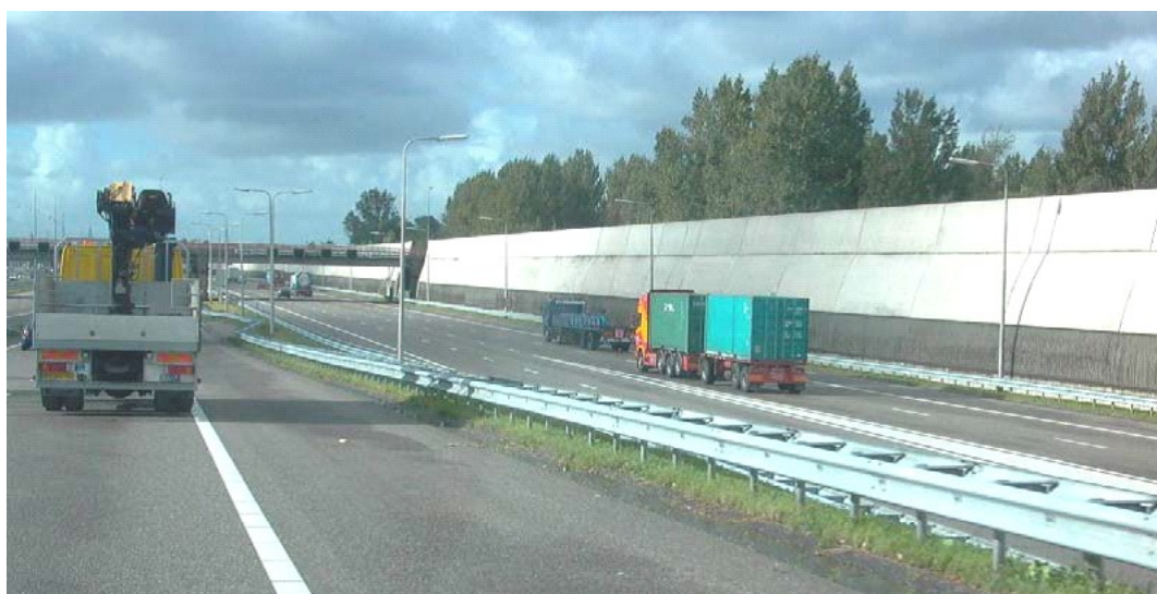
Σχήμα 3-10: Ηχοπέτασμα σκυροδέματος, σχεδίασης γκρι-λευκού σε αυτοκινητόδρομο της Ολλανδίας Πηγή: Danish Road Institute Report 174,2009
