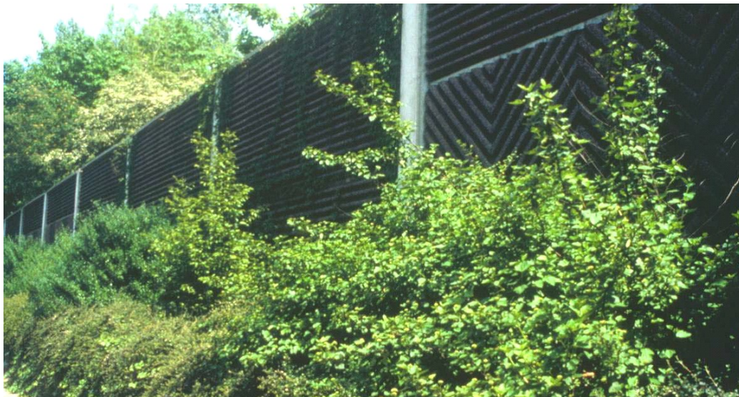
Σχήμα 3-11: Καφέ αντιθορυβικό πέτασμα σκυροδέματος 4m με δεντροφύτευση, Γερμανία
