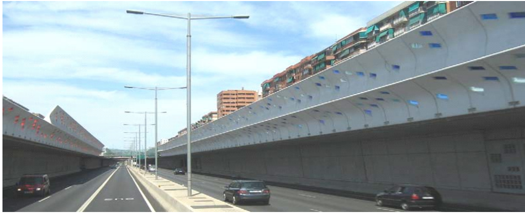
Σχήμα 3-12: Αυτοκινητόδρομος με λευκά αντιθορυβικά πετάσματα από σκυρόδεμα, Βαρκελώνη, Ισπανία Πηγή: Danish Road Institute Report 174,2009
