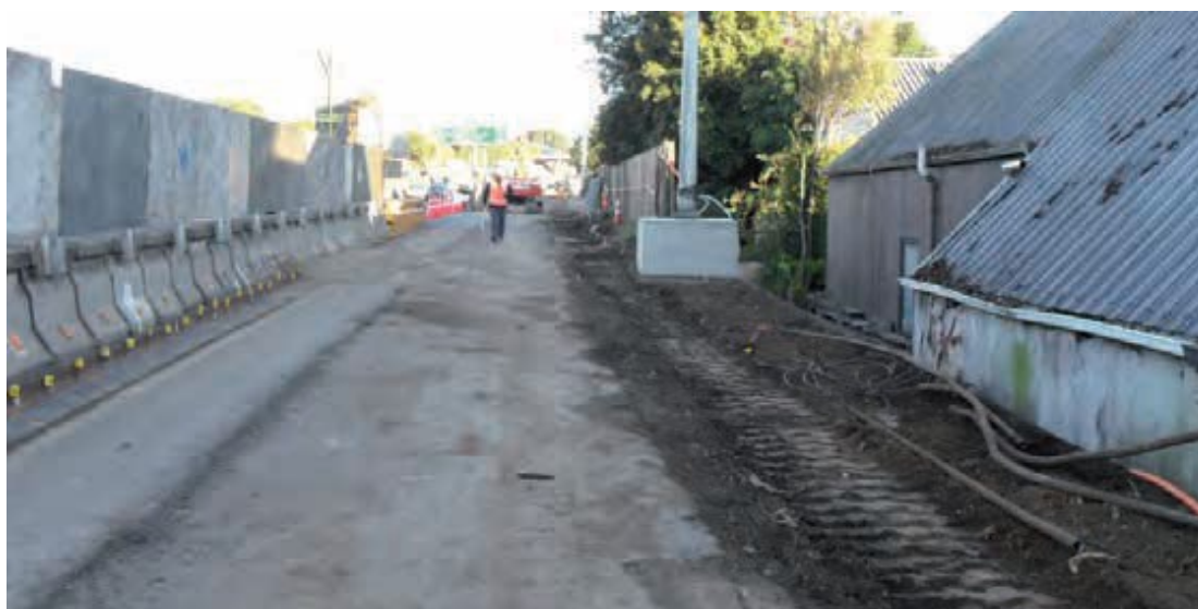
Σχήμα 4-2: Κατοικίες που βρίσκονταν λιγότερο από μισό μέτρο από τις εργασίες, σε ήδη επιβαρυσμένο περιβάλλον υψηλού θορύβου δίπλα στον Νότιο αυτοκινητόδρομο.
