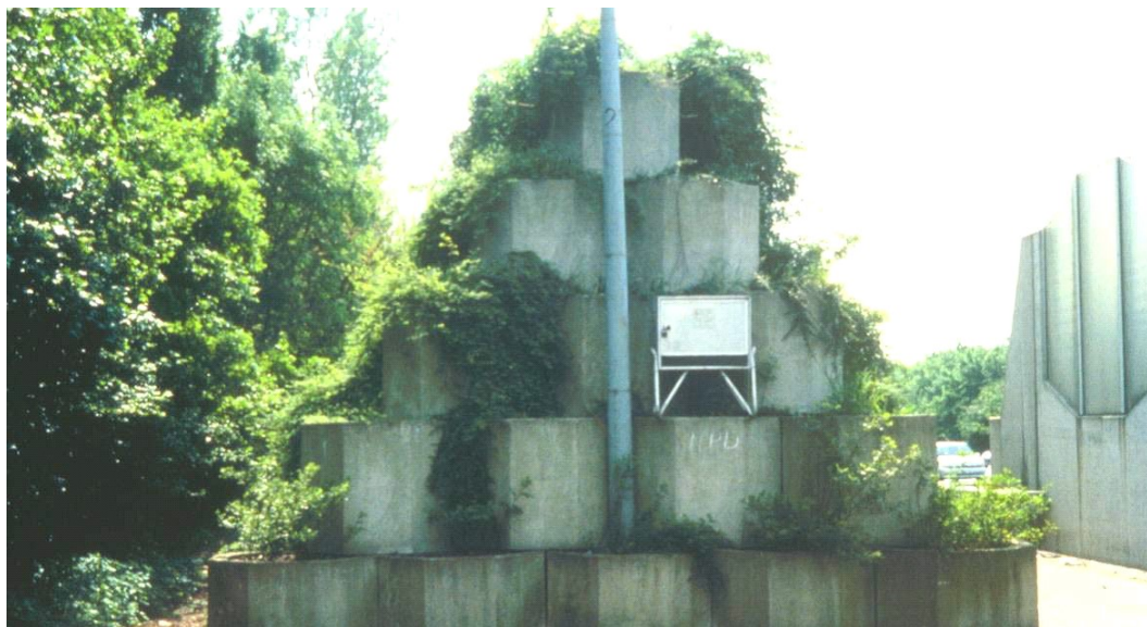
Σχήμα 3-21: Υποστηριζόμενη εδαφική διαμόρφωση με στύλους σκυροδέματος, Γερμανία.
