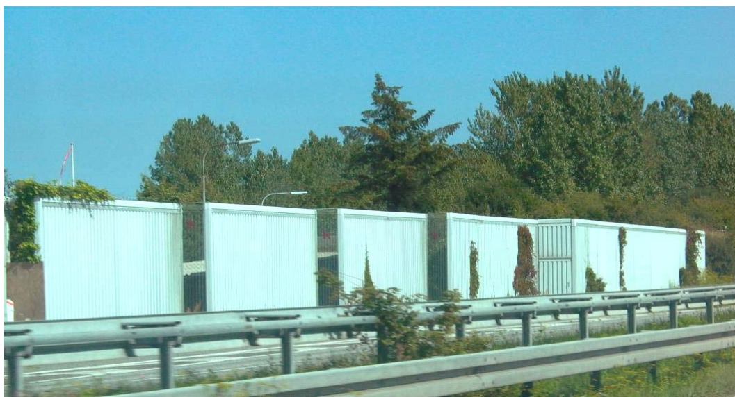
Σχήμα 3-23: Πετάσμα από PVC με κάθετα διαφανή στοιχεία, Δανία Πηγή: Danish Road Institute Report 174,2009
