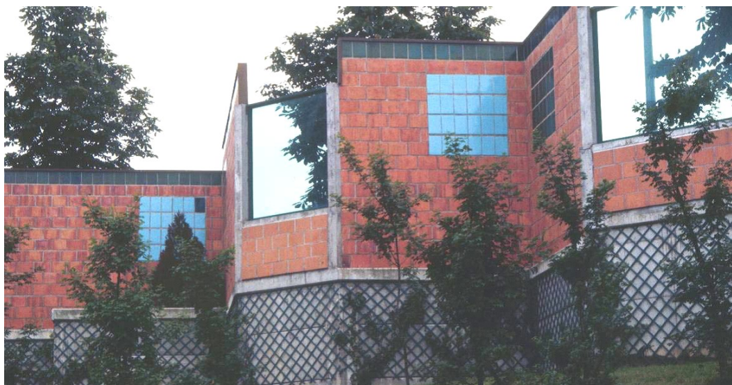
Σχήμα 3-22: Αντιθορυβικό πέτασμα από τούβλα και αισθητικές λεπτομέρειες, Παρίσι Πηγή: Danish Road Institute Report 174,2009
