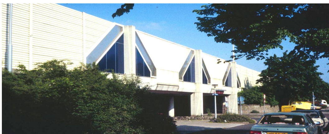
Σχήμα 3-15: Μικτό μεταλλικό αντιθορυβικό πέτασμα με Plexiglass ύψους 5m., Ολλανδία Πηγή: Danish Road Institute Report 174,2009
