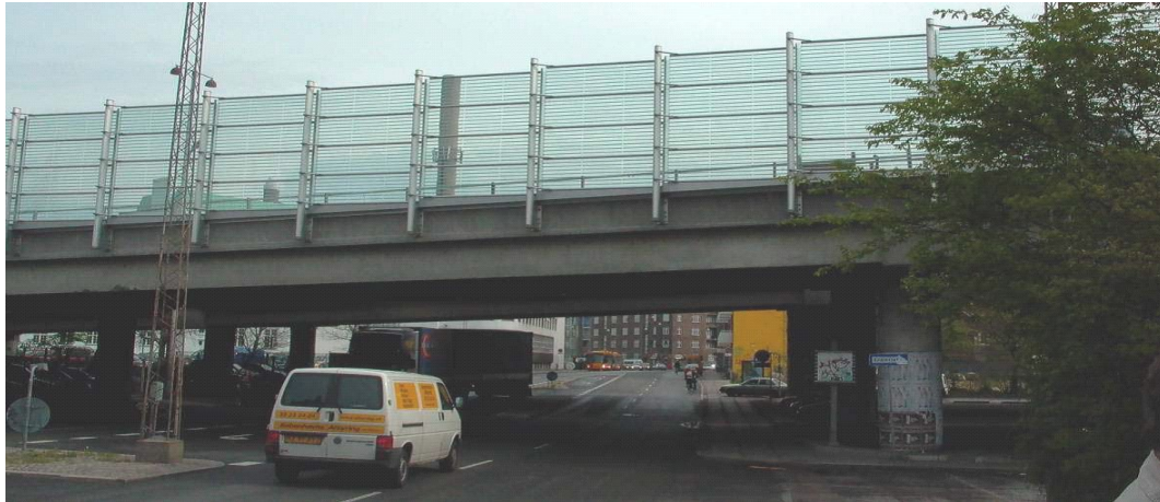
Σχήμα 3-1: Διαφανές αντιθορυβικό πέτασμα σχεδιασμένο για γέφυρα αυτοκινητόδρομου, Κοπεγχάγη, Δανία Πηγή: Danish Road Institute Report 174,2009
