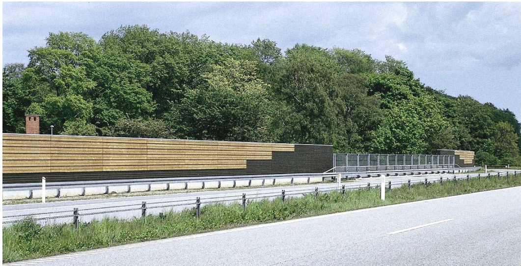
Σχήμα 3-6: Διαφανές τμήμα ξύλινου πετάσματος, Δανία Πηγή: Danish Road Institute Report 174,2009
