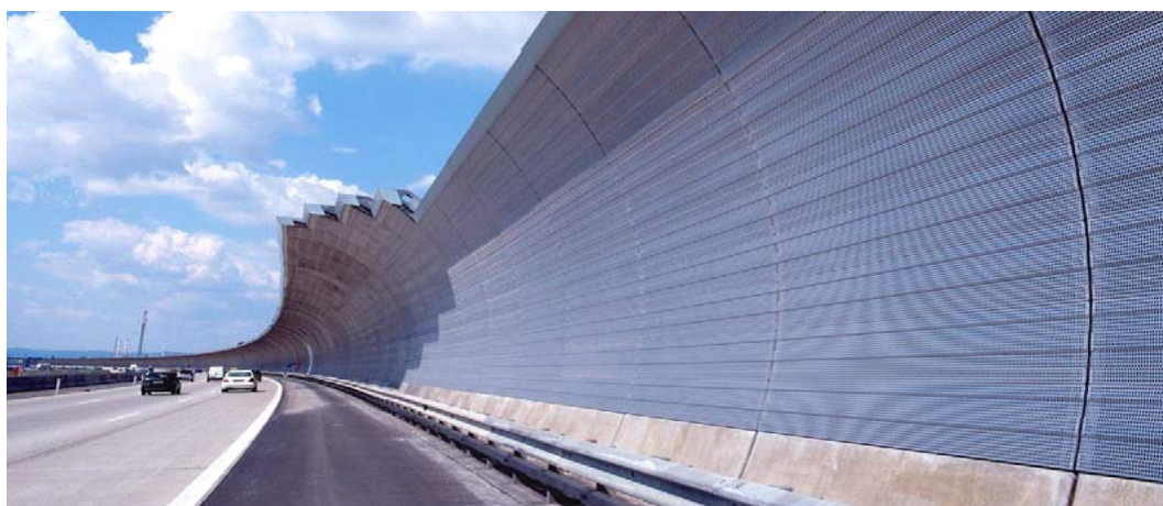
Σχήμα 3-16: Μεταλλικό αντιθορυβικό πέτασμα στη Βιέννη, Αυστρία Πηγή: Danish Road Institute Report 174,2009
