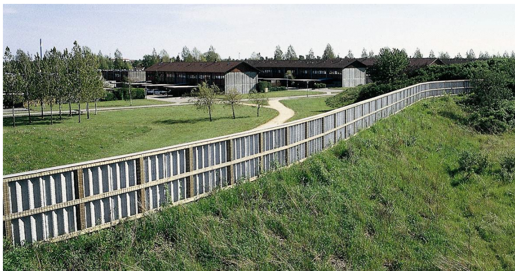
Σχήμα 3-18: εδαφική διαμόρφωση ύψους 1,5 m στη Κοπεγχάγη, Δανία. Πηγή: Danish Road Institute Report 174,2009
