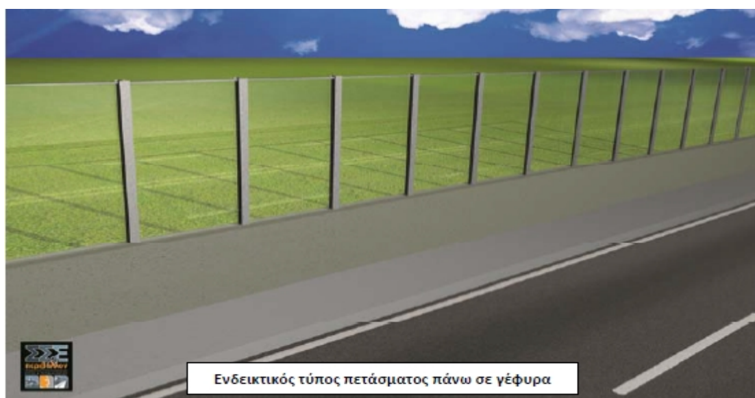
Σχήμα 4-18: Φωτορεαλιστική απεικόνιση ενδεικτικού τύπου μικτού αντιθορυβικού πετάσματος Β, πάνω σε γέφυρα. Πηγή: Σ.Σ.Ε& Περιβάλλον Α.Ε
