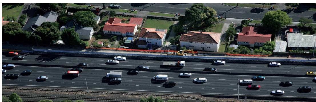
Σχήμα 4-1: Φωτογραφία του έργου Newmarket υπό κατασκευή. Πηγή: Noise
