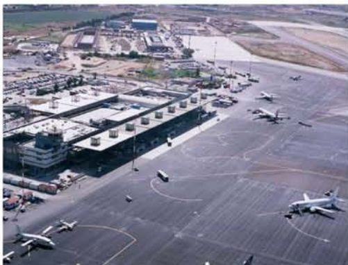
Διεθνής Αερολιμένας Θεσσαλονίκης. Πηγή: http://rideanddrive.gr/luftverkehr.html
