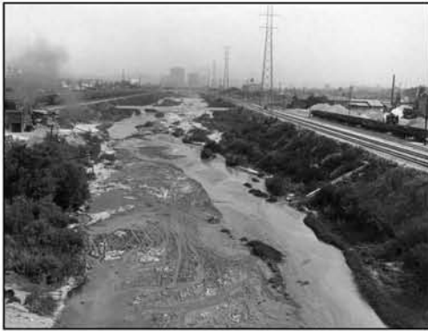
Εικόνες 2.15 &amp; 2.16: Πριν και μετά την κατασκευή του καναλιού
