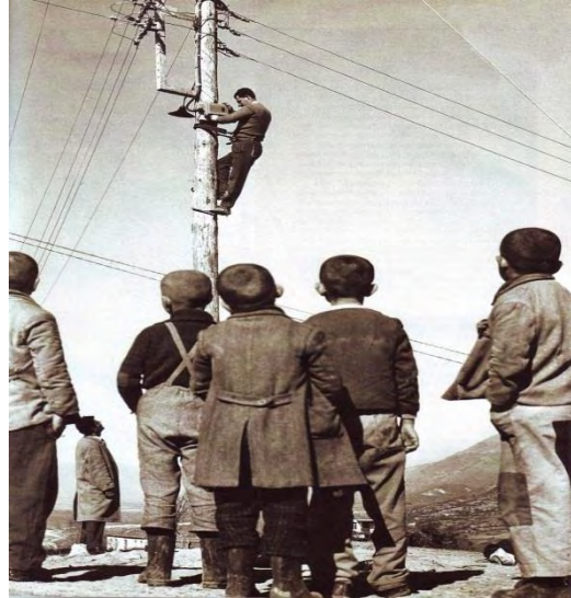
Εικόνα 11: Εργασίες επέκτασης του δικτύου ηλεκτρικού ρεύματος (πηγή: http://amfictyon.blogspot.gr/2014/10/blog-post_29.html )
