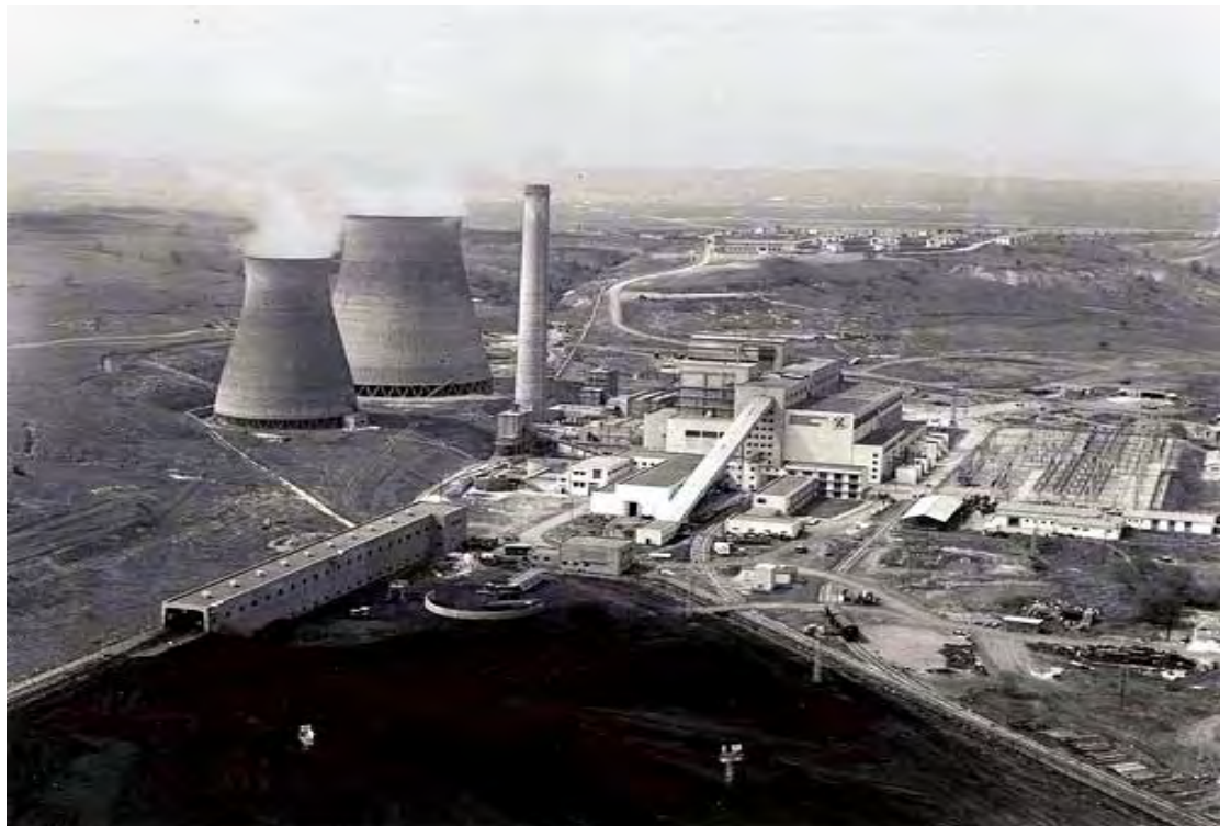
Εικόνα 10: Αποπεράτωση το 1959 του θερμοηλεκτρικού σταθμού Πτολεμαΐδας (πηγή: Ηλεκτρονικό Αρχείο ΔΕΗ Α.Ε.)
