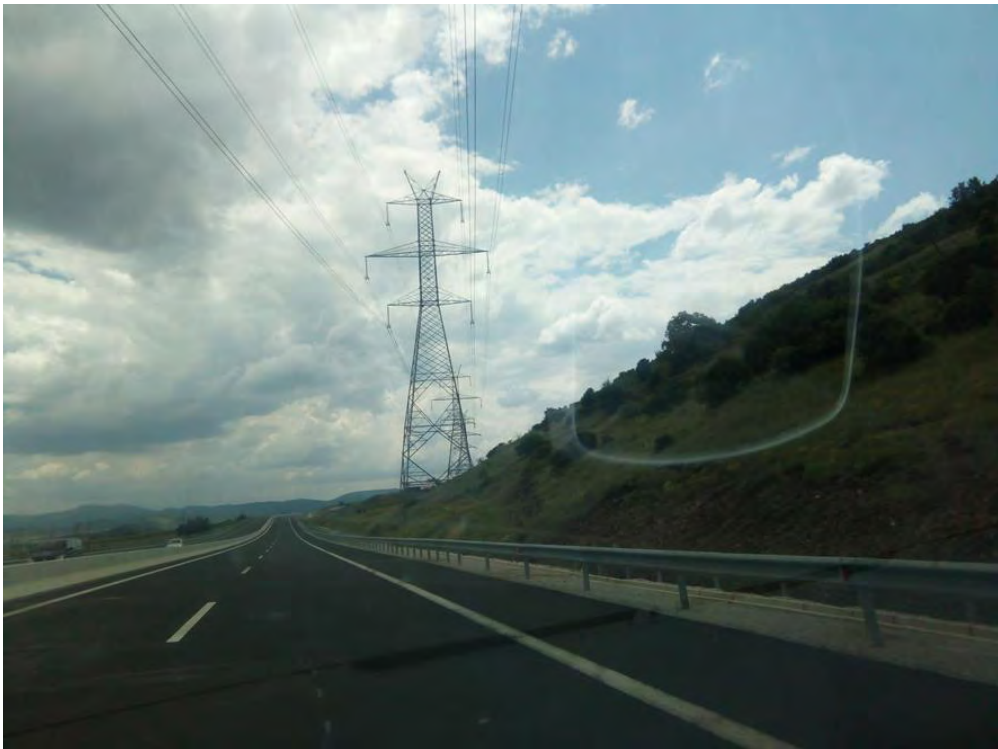
Εικόνα 19: Διασταύρωση με δίκτυο υψηλής τάσης
