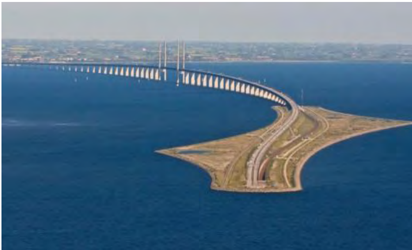
Εικόνα 7: Γέφυρα Øresund, Σουηδία-Δανία
