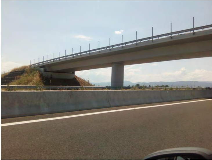
Εικόνα 12: Γέφυρα σύνδεσης επαρχιακών οδών στη ΔΕ Σοφάδων
