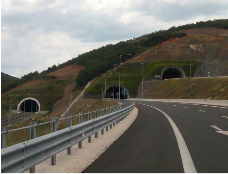
Εικόνα 16: Σήραγγες E-65 πριν τον Άγιο Στέφανο και σιδηροδρομική σήραγγα
