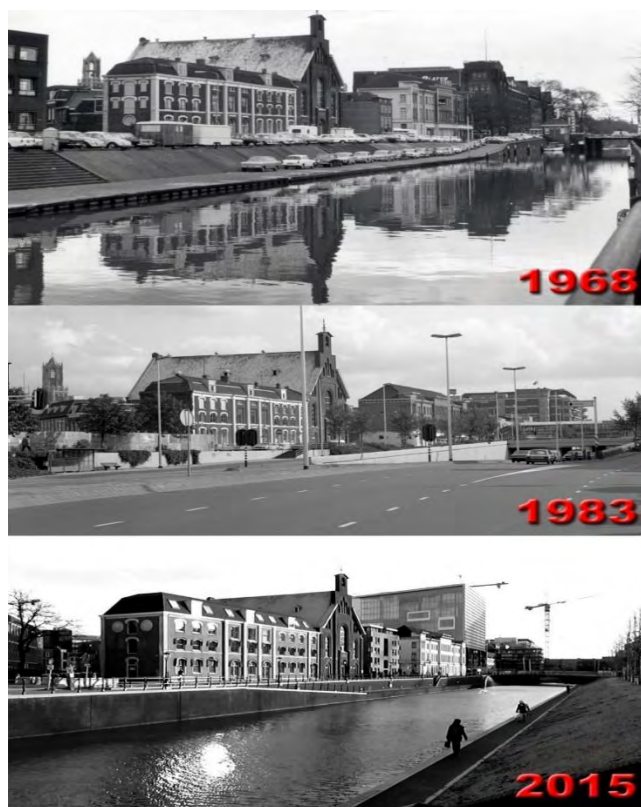
Εικόνα 2.8: Κανάλι→Αυτοκινητόδρομος→Κανάλι, Ουτρέχτη (Bicycle Dutch, 2017)
