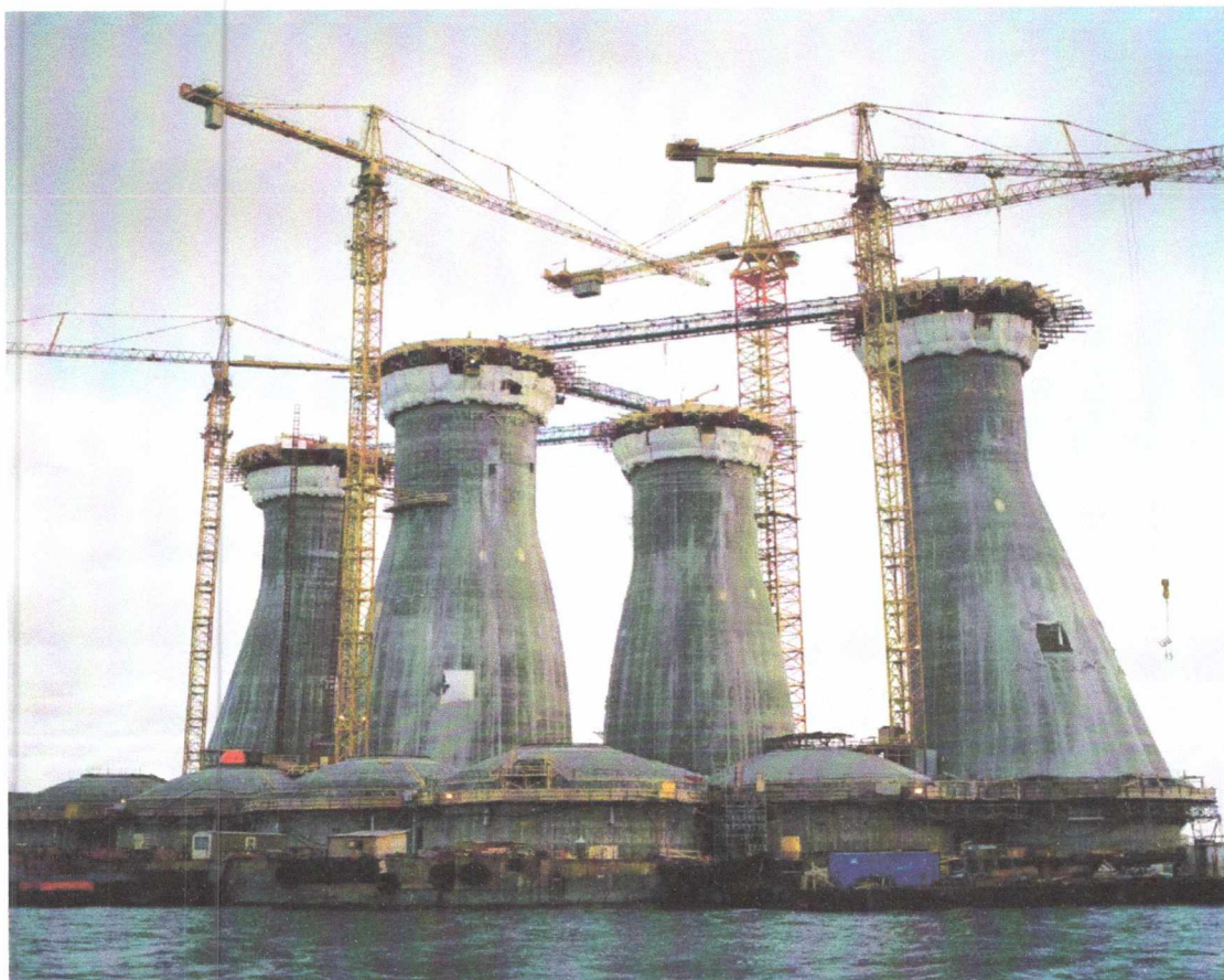
Εικόνα 3.8: Κολώνες μεταβαλλόμενης διατομής και κύλινδροι σκυροδέματος στη βάση
