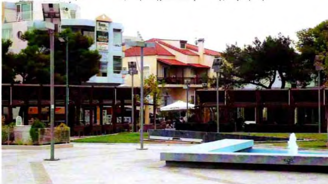
Εικόνα 13: Τα 'φωτοβολταϊκά' στέγαστρα της Πλατείας Αναλήψεως, Βριλησίων
