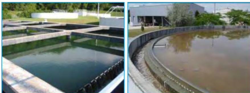
Εικόνα 5.3.4.1. Άποψη ορθογώνιας και κυκλικής δεξαμενής καθίζησης
