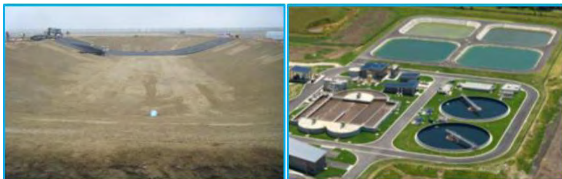
Εικόνα 5.4.6.1. Δεξαμενές ή λίμνες σταθεροποίησης λυμάτων
