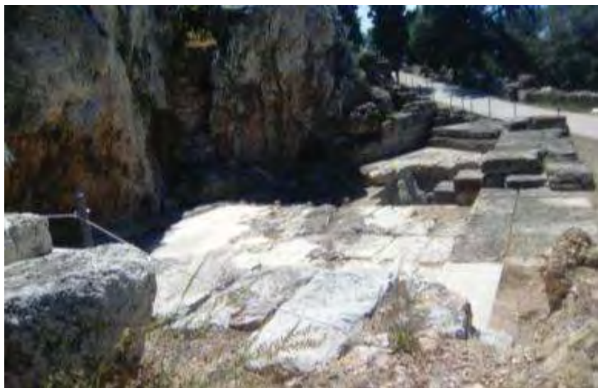
Εικόνα 1 Τμήμα της πλακόστρωτης αυλής της κρήνης κλειψύδρας όπως σώζεται στη σύγχρονη εποχή
