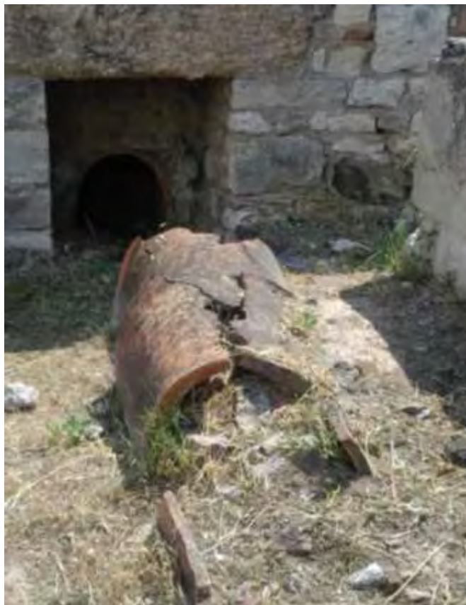
Εικόνα 2 Πήλινος αγωγός που τροφοδοτούσε με νερό την κρήνη στη Νότια Στοά II
