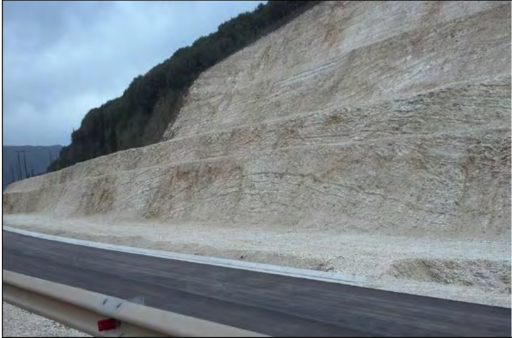
Εικόνα 14. Όρυγμα σε περιοχή της Εθνικής Οδού Ε55
