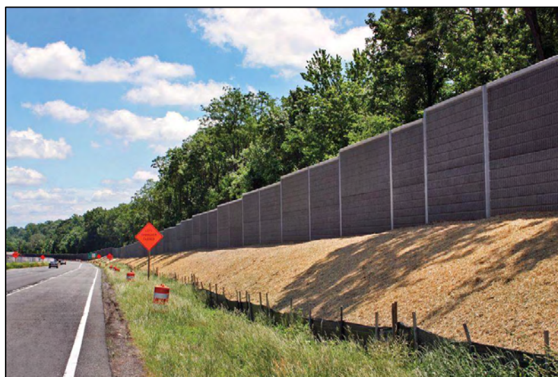
Εικόνα 24. Ηχοπέτασμα από σκυρόδεμα σε δρόμο της Ουάσιγκτον
