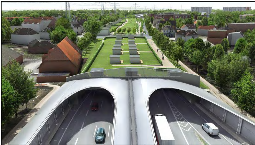
Εικόνα 13. Τούνελ cut and cover υπό κατασκευή στον αυτοκινητόδρομο Α7 της Γερμανίας
