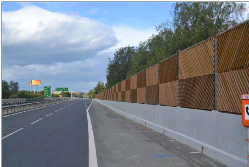
Εικόνα 20. Ηχοπέτασμα με ξύλινα στοιχεία στον Αυτοκινητόδρομο Λεμεσού
