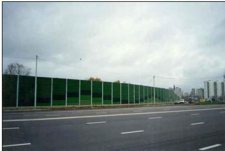
Εικόνα 21. Παράδειγμα μεταλλικού ηχοπετάσματος
