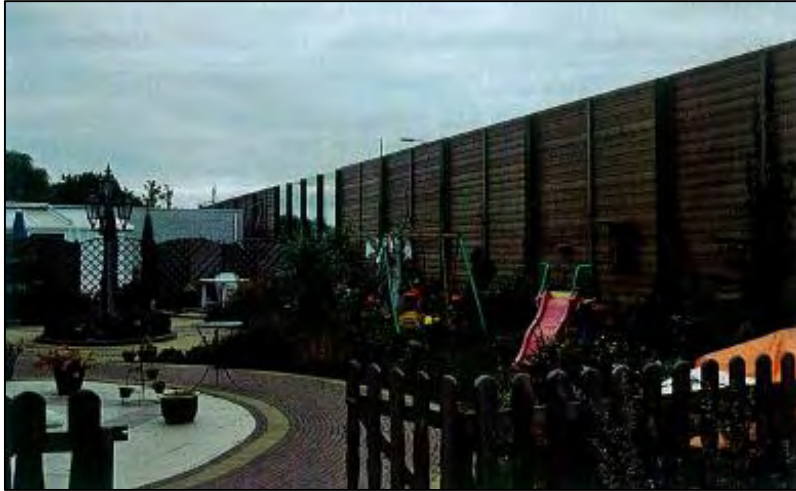
Εικόνα 19. Ξύλινο ηχοπέτασμα σε περίφραξη κήπου
