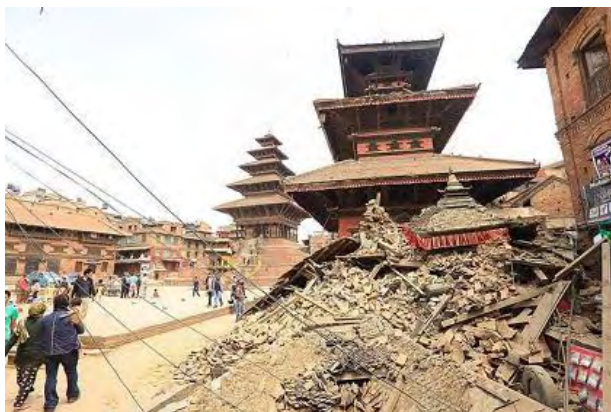
Εικόνα 15 Κατάρρευση ιστορικών κτιρίων στο Νεπάλ (UNISDR, 2017)
