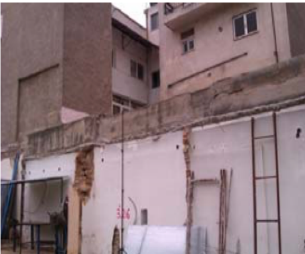
ΕΙΚΟΝΑ 22 Εργοτάξιο «ΜΑΝΙΑΤΙΚΑ»- ΑΥΤΟΝΟΜΟΣ ΚΙΝΗΤΟΣ ΣΤΑΘΜΟΣ ΘΟΥΡΥΒΟΥ ΜΕ ΣΤΑΤΙΣΤΙΚΟ ΑΝΑΛΥΤΗ ΚΑΙ ΔΙΑΤΑΞΗ ΠΑΝΤΟΣ ΚΑΙΡΟΥ (ΣΕ ΕΙΔΙΚΟ ΙΣΤΟ) ΤΥΠΟΥ
