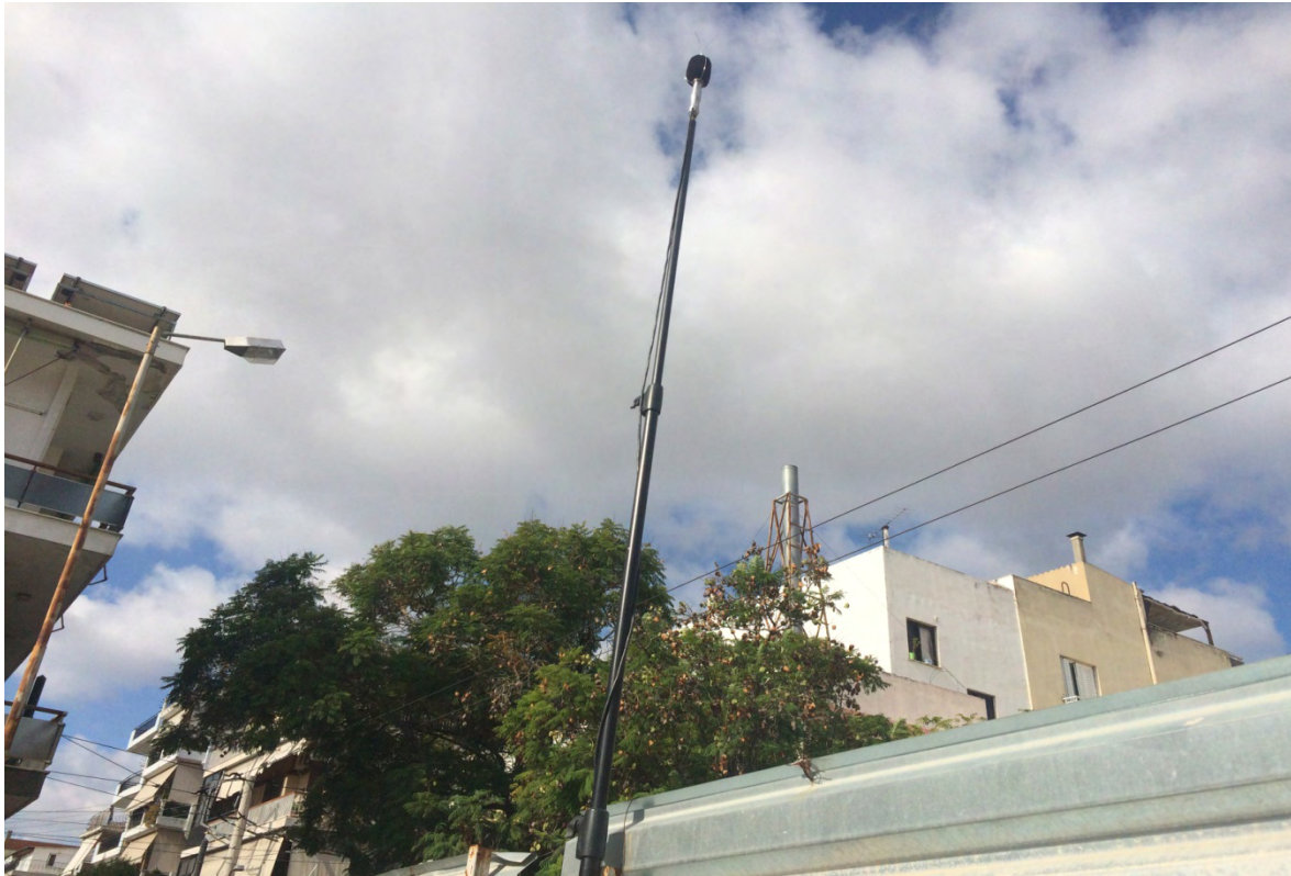
ΕΙΚΟΝΕΣ 7.2, 7.3: ΕΡΓΟΤΑΞΙΟ «ΝΙΚΑΙΑ»- ΑΥΤΟΝΟΜΟΣ ΚΙΝΗΤΟΣ ΣΤΑΘΜΟΣ ΘΟΡΥΒΟΥ ΜΕ ΣΤΑΤΙΣΤΙΚΟ ΑΝΑΛΥΤΗ ΚΑΙ ΔΙΑΤΑΞΗ ΠΑΝΤΟΣ ΚΑΙΡΟΥ (ΣΕ ΕΙΔΙΚΟ ΙΣΤΟ) ΤΥΠΟΥ SOLO
