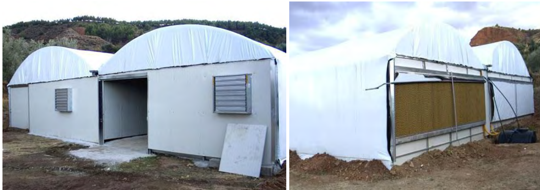
Εικόνα 17. Μονάδα εκτροφής μεταξοσκώληκα τύπου «τολλ» με σύστημα δροσισμού. Αριστερά φαίνεται η πρόσθια πλευρά με τους ανεμιστήρες και δεξιά η οπίσθια πλευρά με το πάνελ δροσισμού (Πηγή: Χαριζάνης Π. & Τζιτζινάκης Μ., Εγχειρίδιο Σηροτροφίας, 2011).
