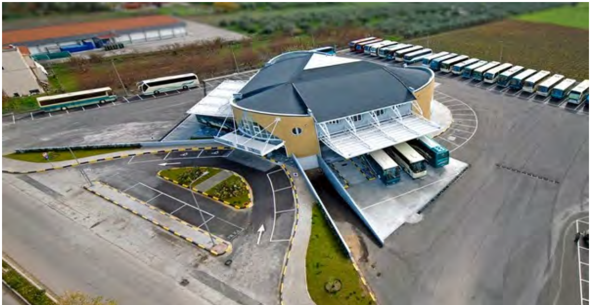
Εικόνα 59: Ο σταθμός του Υπεραστικού ΚΤΕΛ (Πηγή: Αρχείο INTERNET)
